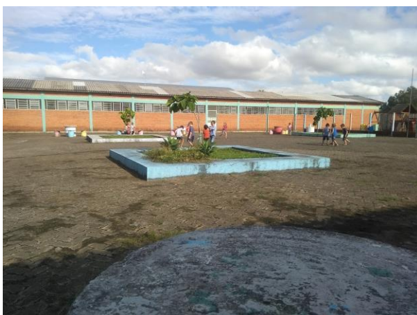
Fotografia 11 - Pátio da Escola B.
