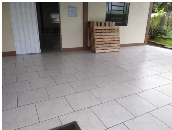
Fotografia 8 - Área aberta Escola A.
