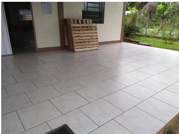
Fotografia 7 - Área aberta Escola A.
