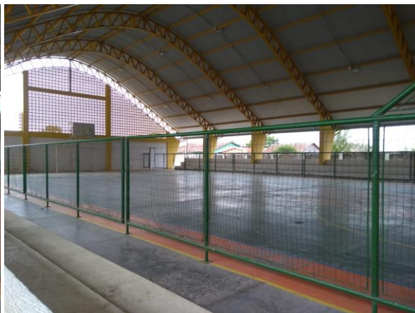
Fotografia 16 - Quadra aberta da Escola B.
