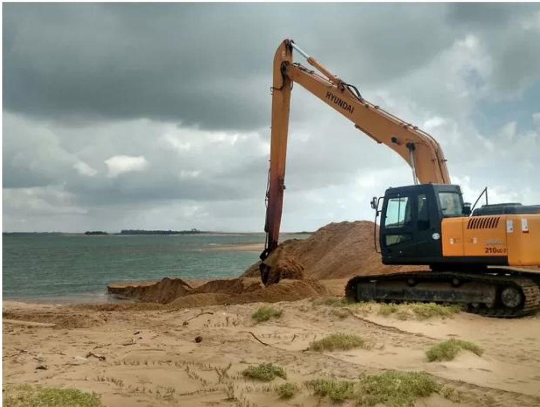
Mais uma escavadeira será enviada ao local (Foto: Kaio Henrique/ TV Gazeta Norte)
