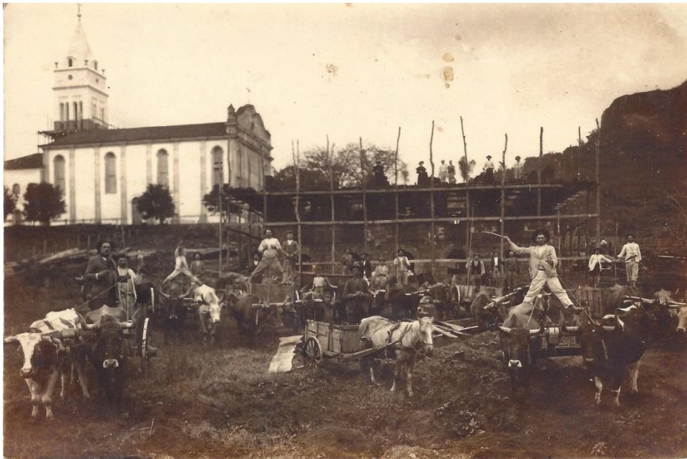
Figura 14: Seminário Rainha dos Apóstolos em Construção, Vale Vêneto/RS
