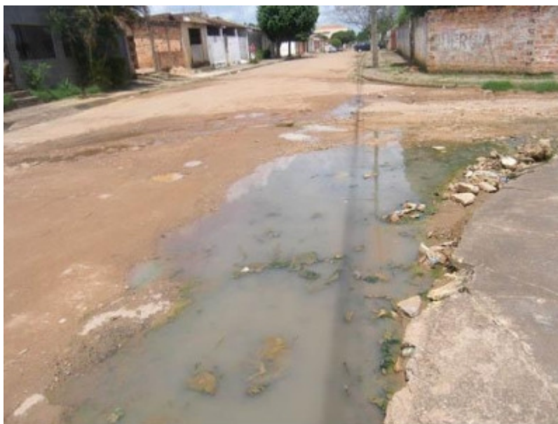
Figura 2 – Esgoto nas proximidades do Arroio Cadena (Vila Oliveira).
