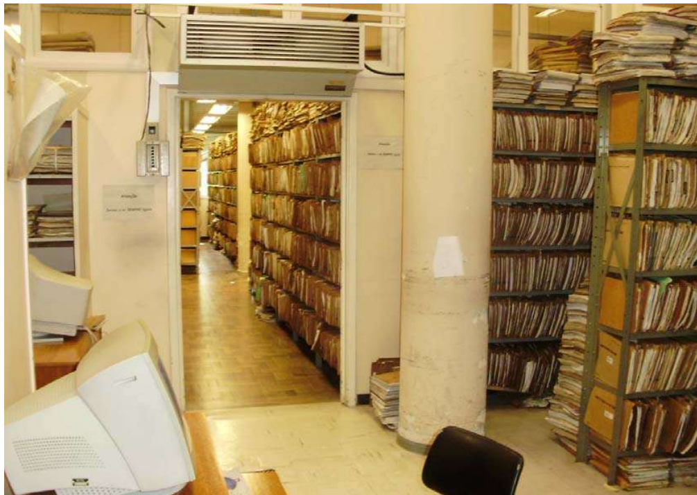
FIGURA 19 :Utilização de condicionadores de ar para refrigeração do ambiente
