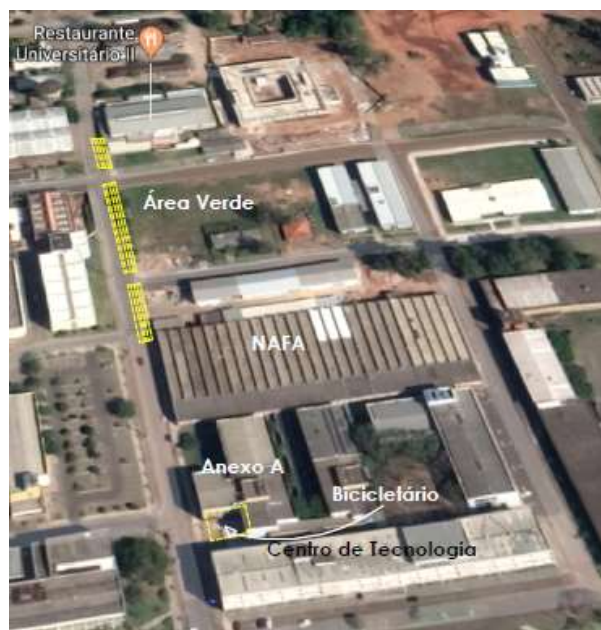
Figura 3 - Imagem do terreno em que a estrutura ficará situada
