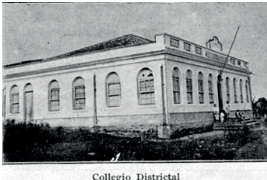
Figura 21- Colégio Distrital, Santa Maria/RS
