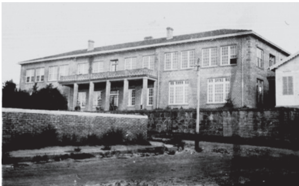
Figura 29- Colégio Metodista Centenário (1922), localizado à Rua Dr. Turi em Santa Maria/RS
