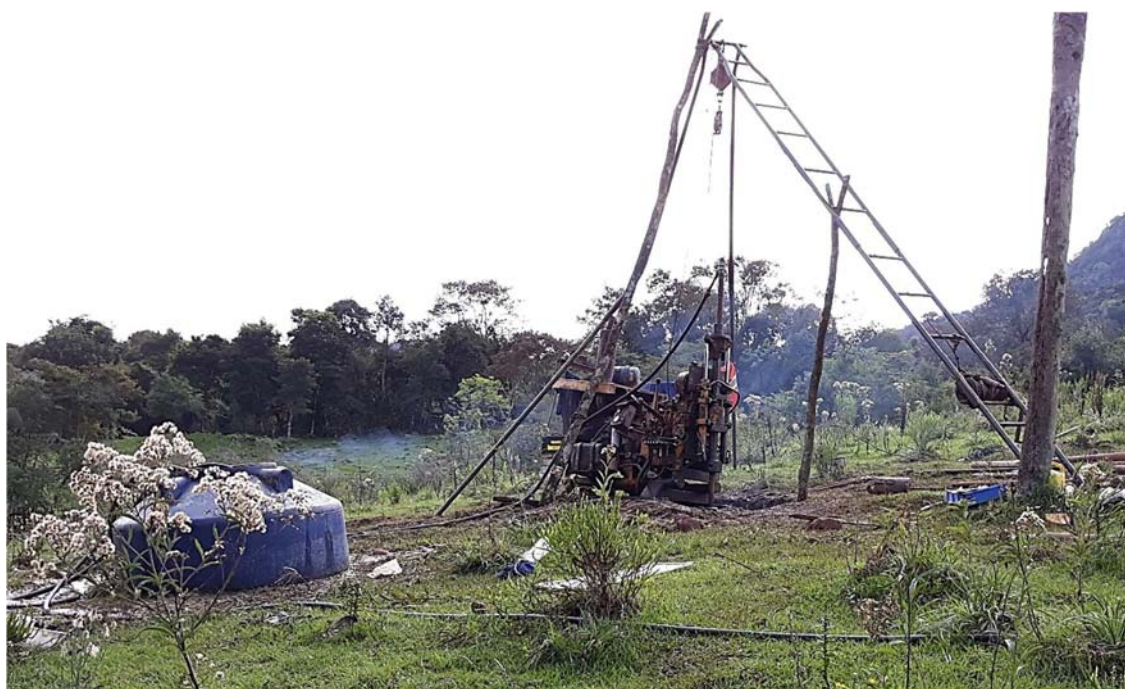
Figura 4.2 – Execução de sondagem mista.
