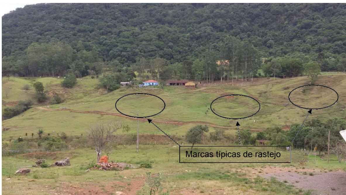
Figura 5.5 – Marcas indicando movimento de rastejo. Encosta oposta da rodovia.
