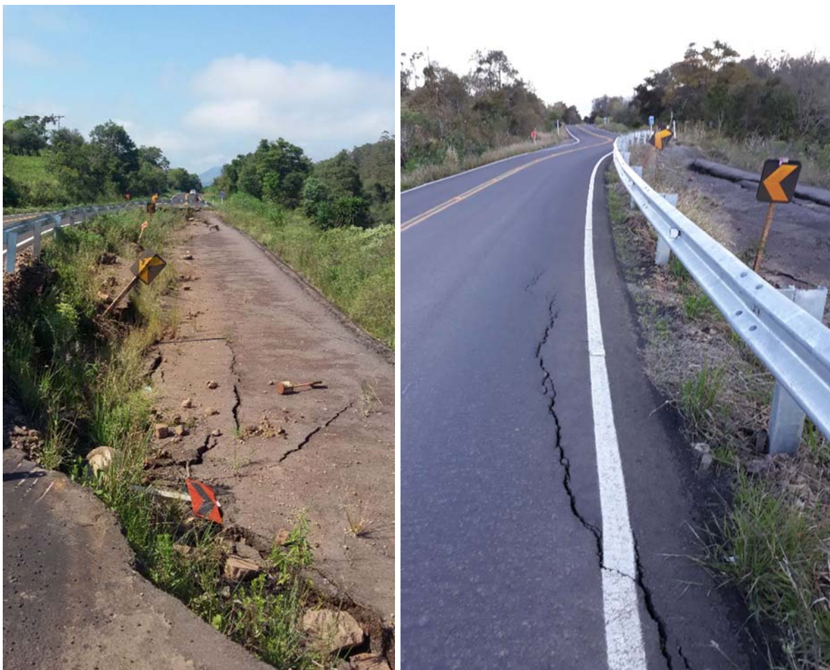
Figura 3.10 – Situação do trecho em fevereiro e maio de 2018.
