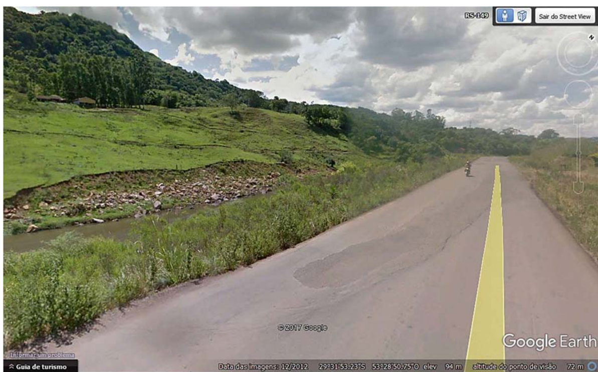
Figura 3.6 – Situação do trecho na RS 149 em dezembro de 2012.
