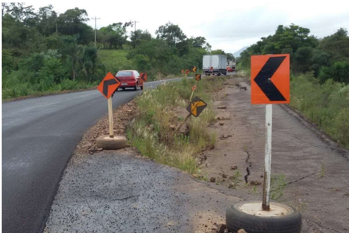
Figura 3.9 – Situação do trecho em janeiro de 2018; desvio asfaltado.
