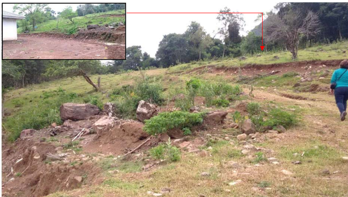
Figura 5.10 – Parte da encosta com rupturas circulares possivelmente relacionadas à mobilização de terra para a terraplanagem da área. Logo após a construção.
