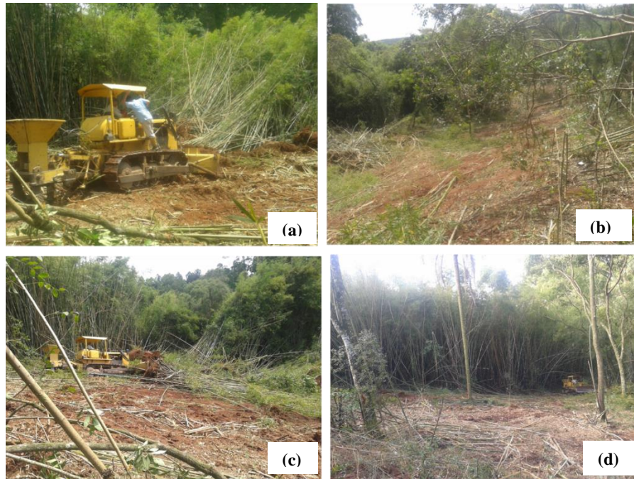
Figura 3 - Aplicação do controle mecânico em área de superabundância de bambus: (a) controle mecânico de arraste com trator de esteira; (b, c, d) aspecto da área após o controle
