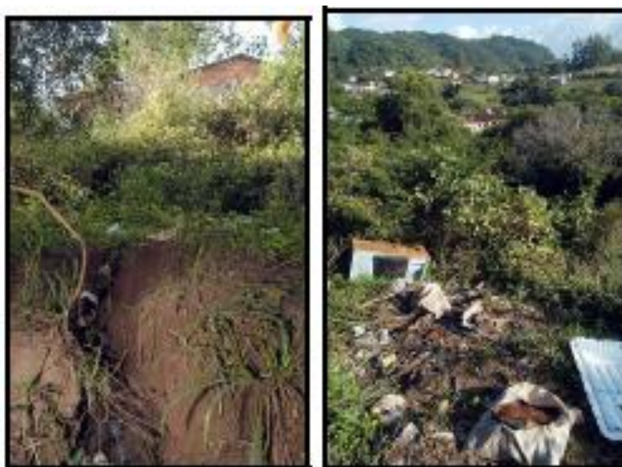
Figura 23 e 24 – Esgotos a céu aberto e lixo espalhado na microbacia (Fonte: Guerra, 2004).
