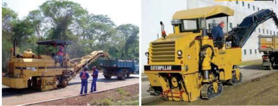
Figura 2 – Fresadora realizando de remoção da camada asfáltica
