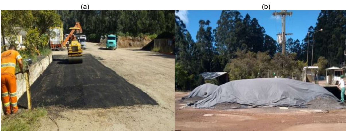
Figura 48 – Local para armazenamento do RAP: preparação do local (a) e material fresado coberto (b)
