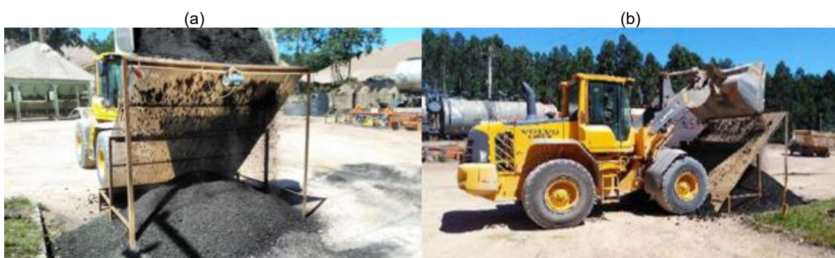
Figura 45 – Processo de separação das frações do RAP: vista inferior (a) do peneiramento e posicionamento da carregadeira (b)
