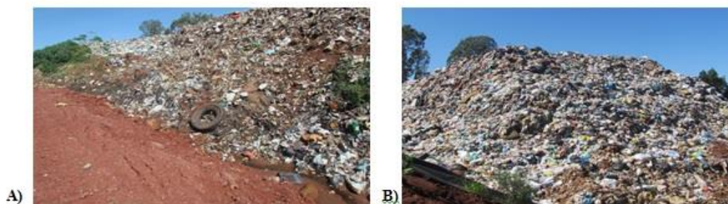
Figura 08 - Disposição de Resíduos. A) Antigas Células de disposição do lixo no solo. B) Célula com geomembrana quase completa de lixo
