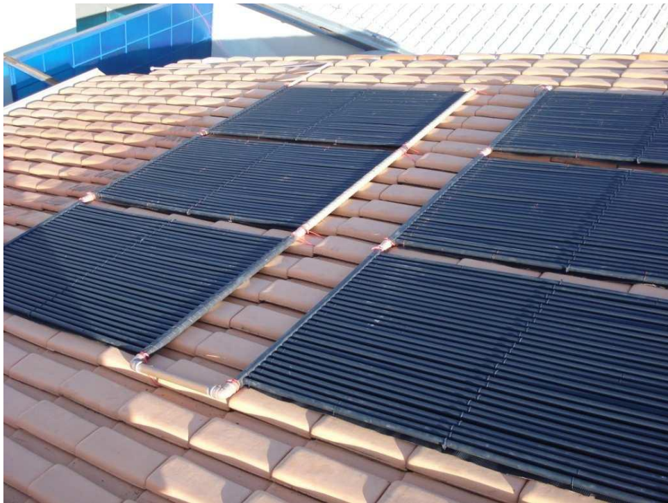
Figura 4 – Aquecedor solar de baixo custo em PVC.
