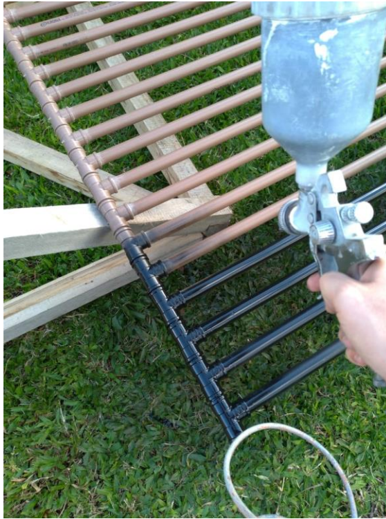
Figura 14 – Processo de pintura do coletor solar.
