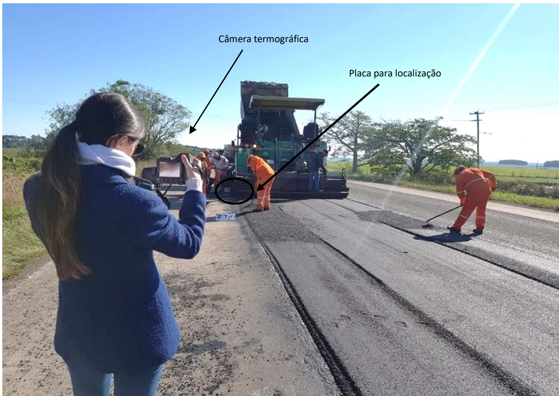
Figura 52 - Acompanhamento de processo construtivo com câmera infravermelha nesta pesquisa
