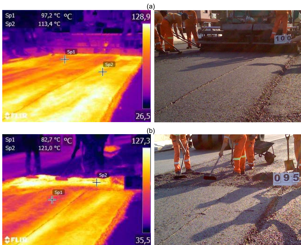
Figura 96 - (a) final de jornada de trabalho com massa asfáltica fria e (b) localização de junta construtiva – Segmento 1 do Trecho ERS-509 desta pesquisa
