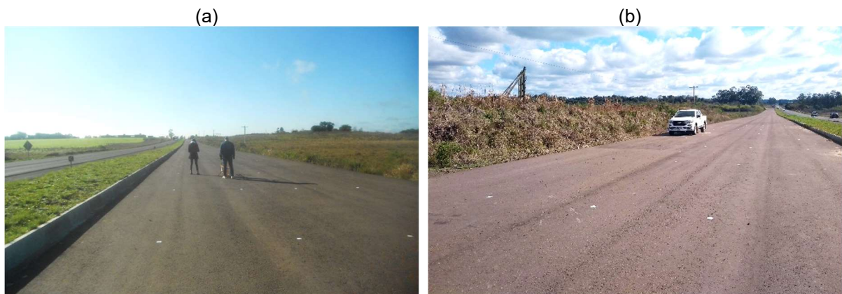
Figura 74 – Primeira camada de concreto asfáltico, com marcação das quatro trilhas de rodas no segmento da BR-287/RS desta pesquisa
