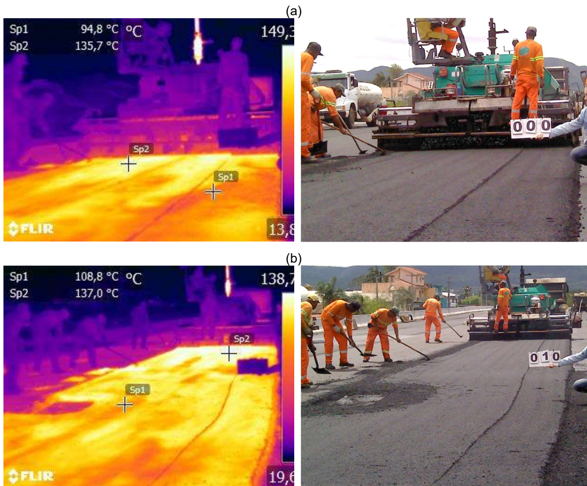
Figura 115 – (a) Distribuição irregular da vibroacabadora e (b) acabamento manual na caixa coletora e na junta longitudinal – Segmento 4 do Trecho ERS-509 desta pesquisa
