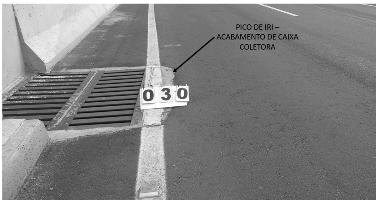
Figura 123 - Proximidades do ponto 30 - bordo externo da faixa interna. Acabamento dado nas proximidades da caixa coletora do Trecho ERS-509 desta pesquisa
