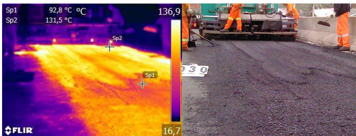
Figura 104 - Após execução de junta transversal, distribuição irregular de CA pela vibroacabadora do Trecho ERS-509 desta pesquisa
