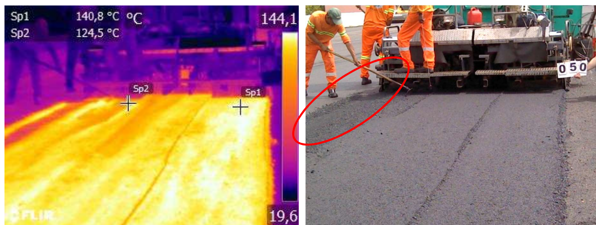
Figura 97 - Execução de junta longitudinal, acabamento manual – Segmento 2 do Trecho ERS-509 desta pesquisa
