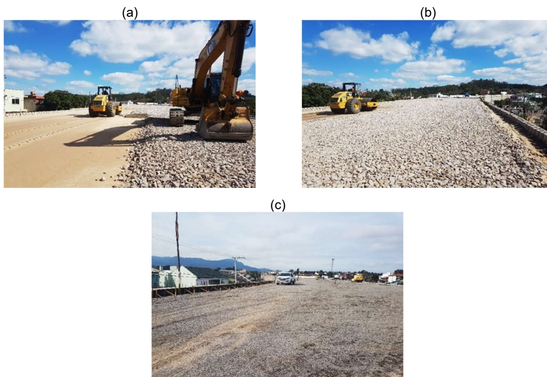
Figura 81- Sequência executiva da camada de sub-base em macadame (a) espalhamento com escavadeira (b) compactação com rolo liso (c) material de enchimento e finalização da camada do Trecho da ERS-509 desta pesquisa
