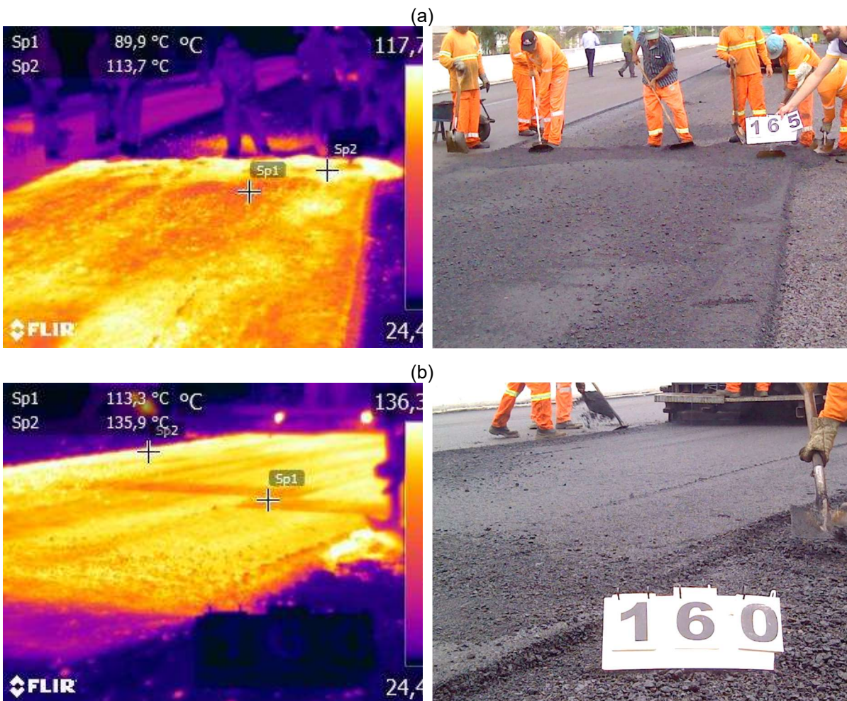
Figura 101 - Execução de junta (a) finalização de um dia de trabalho e (b) retomada das atividades do Trecho ERS-509 desta pesquisa
