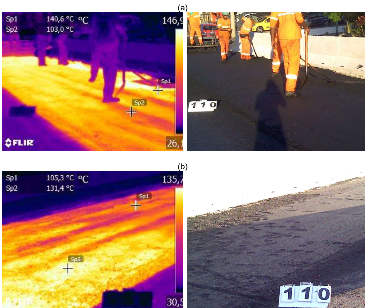
Figura 117 - Acabamento manual e marcação de pés/botinas no pano de execução – Segmento 4 do Trecho ERS-509 desta pesquisa
