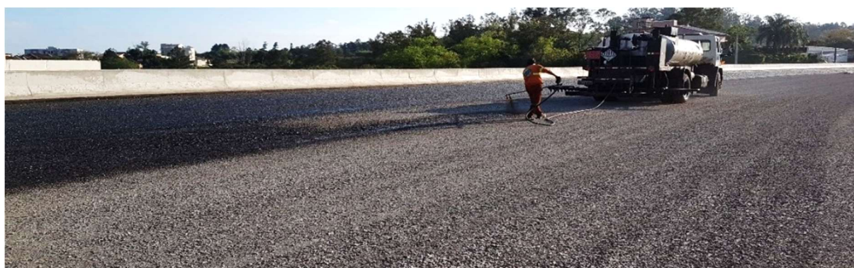
Figura 82 - Camada de base finalizada recebendo a aplicação de imprimação do Trecho da ERS-509 desta pesquisa
