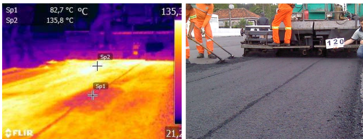
Figura 103 – Exemplo de diferenciais de temperatura no pano de execução do Trecho ERS-509 desta pesquisa
