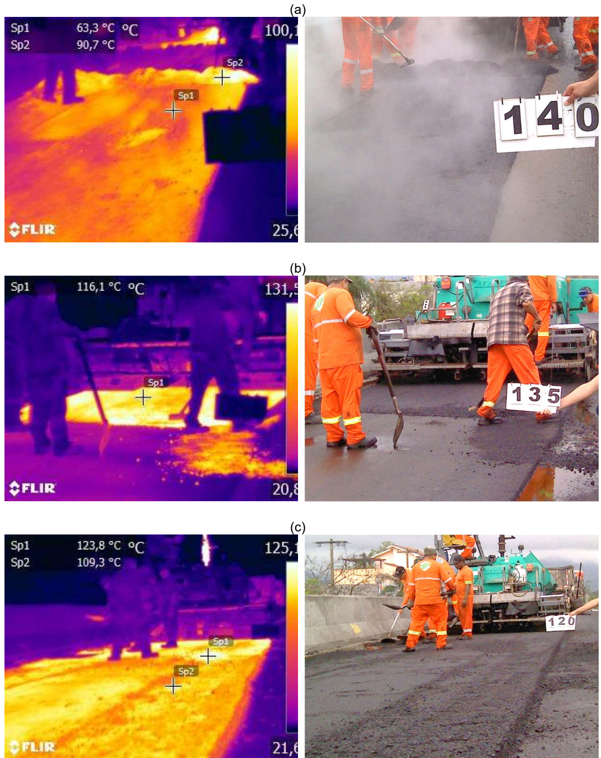
Figura 99 - Segmento executado com chuva (a) pano de execução com massa fria e localização de junta transversal, (b) execução de junta fria – retomada das atividades com água empoçadas da superfície e (c) segmento executado com vibroacabadora e massa fria – Segmento 3 do Trecho ERS-509 desta pesquisa
