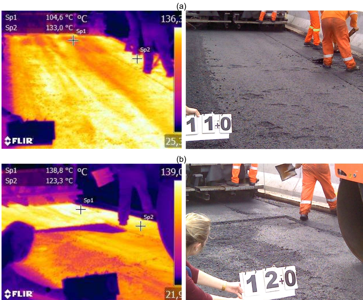
Figura 98 - (a) Acabamento manual da junta longitudinal e nas proximidades da barreira de concreto e (b) distribuição irregular da vibroacabadora – Segmento 2 do Trecho ERS-509 desta pesquisa
