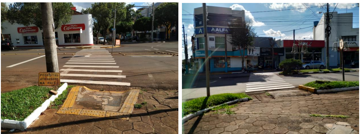
Figura 23 – Rebaixamento da calçada para travessia de pedestres da quadra de referência 01
