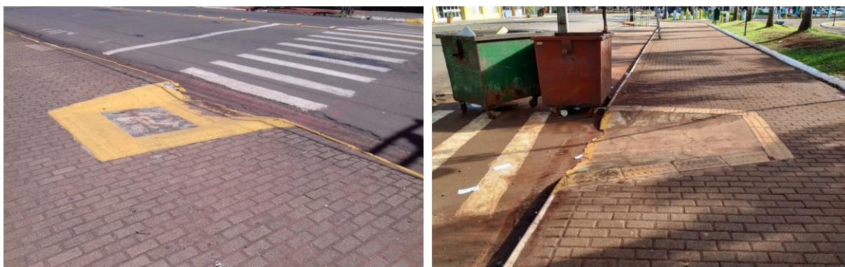
Figura 30 – Rebaixamento da calçada e faixa de travessia da quadra de referência 03
