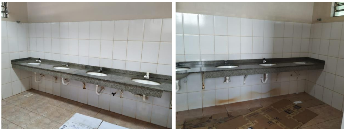
Figura 47 – Bancada de lavatórios do sanitário feminino e masculino, respectivamente
