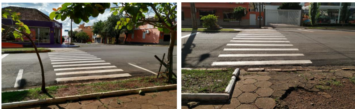
Figura 33 – Rebaixamento de calçada na quadra de referência 04
