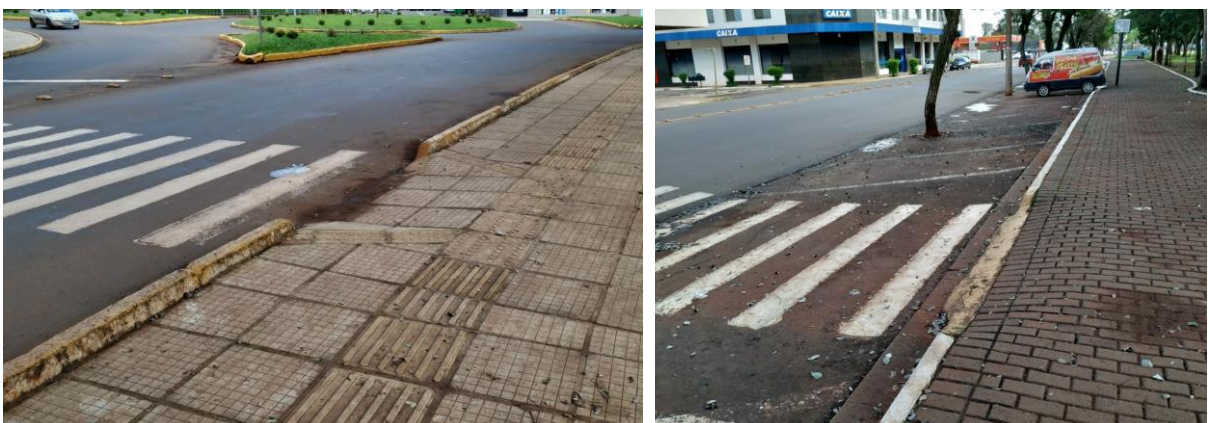
Figura 42 – Faixas de travessias e rebaixamento de calçada na quadra de referência 07
