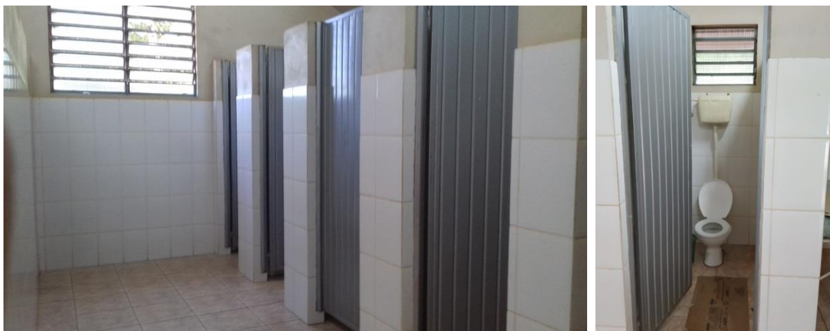
Figura 45 – Boxes comuns do sanitário feminino
