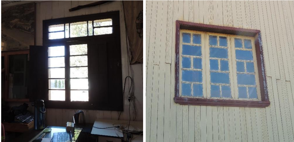
Figura 19 – Janelas do Museu Municipal e do Moinho Richter, respectivamente, com suas três folhas de abertura.
