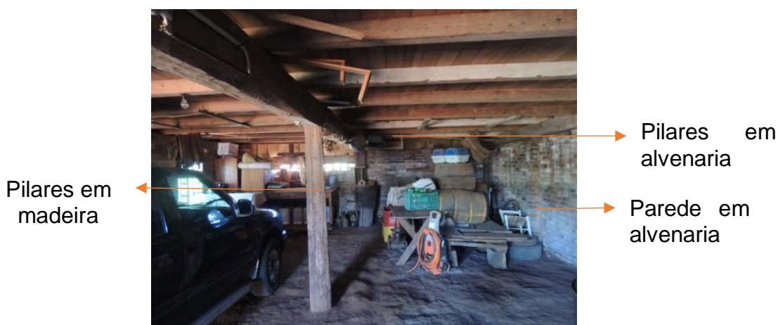
Figura 17 - Porão com pilares em alvenaria e madeira e paredes em alvenaria.
