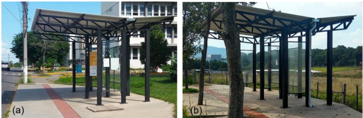
Figura 41- Abrigos de ônibus modelo padrão da UFSM instalados CCSH (a) e HVU (b).
