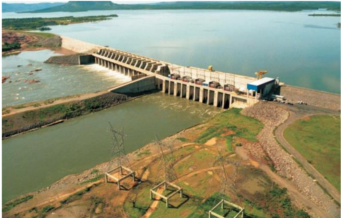
Figura 12. Usina hidrelétrica Luis Eduardo Magalhães.
