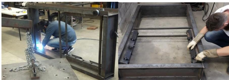
Figura 12 - Finalização do suporte e preenchimento da caixa com concreto
