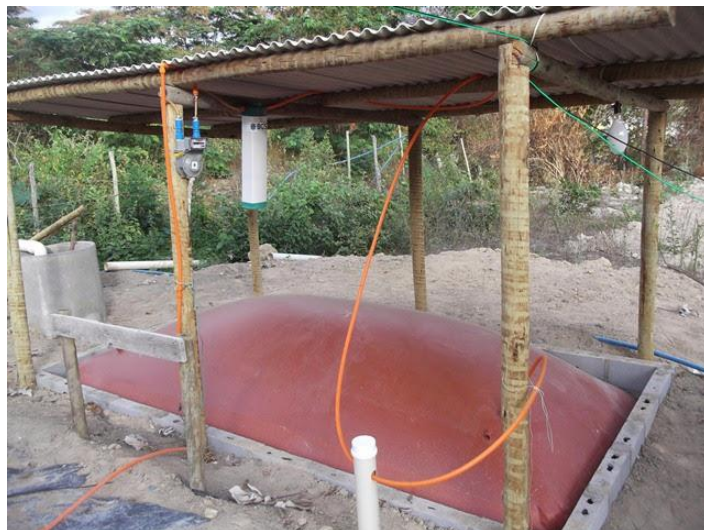
Figura 11 - Biodigestor anaeróbio para fins energéticos e sua estrutura de proteção
