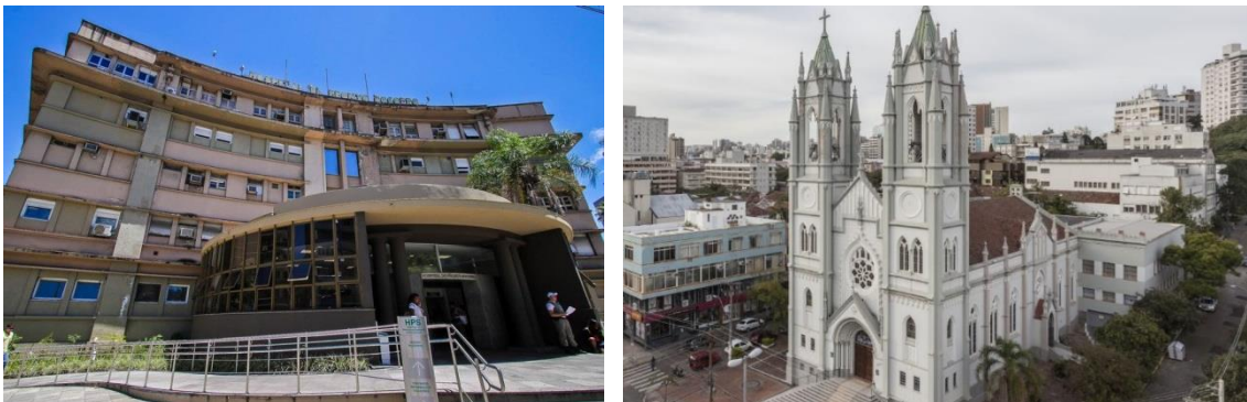
Figura 19 - (a) Hospital de Pronto Socorro de Porto Alegre; (b) Paróquia São Pedro.
