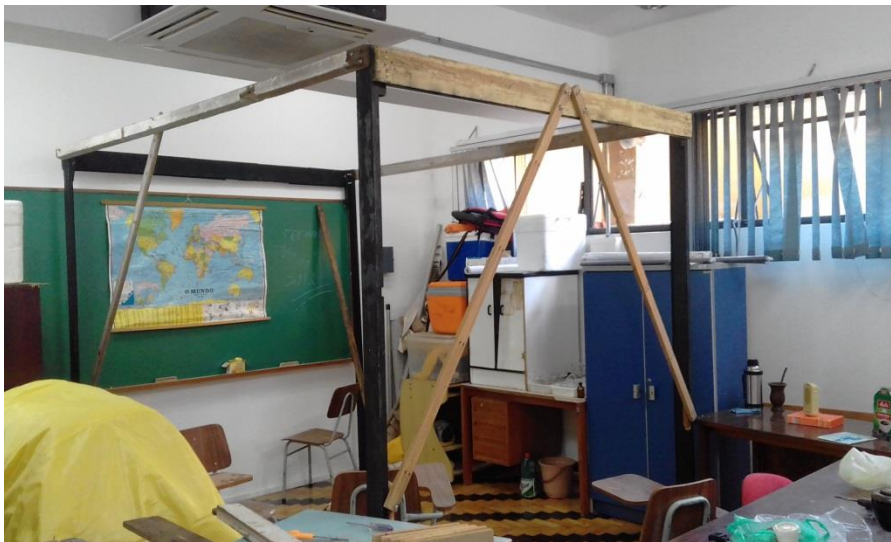
Figura 32: Sala escura em construção. A estrutura em madeira foi coberta por uma camada de tecido em cor preta (TNT) e duas camadas de lona plástica preta.
