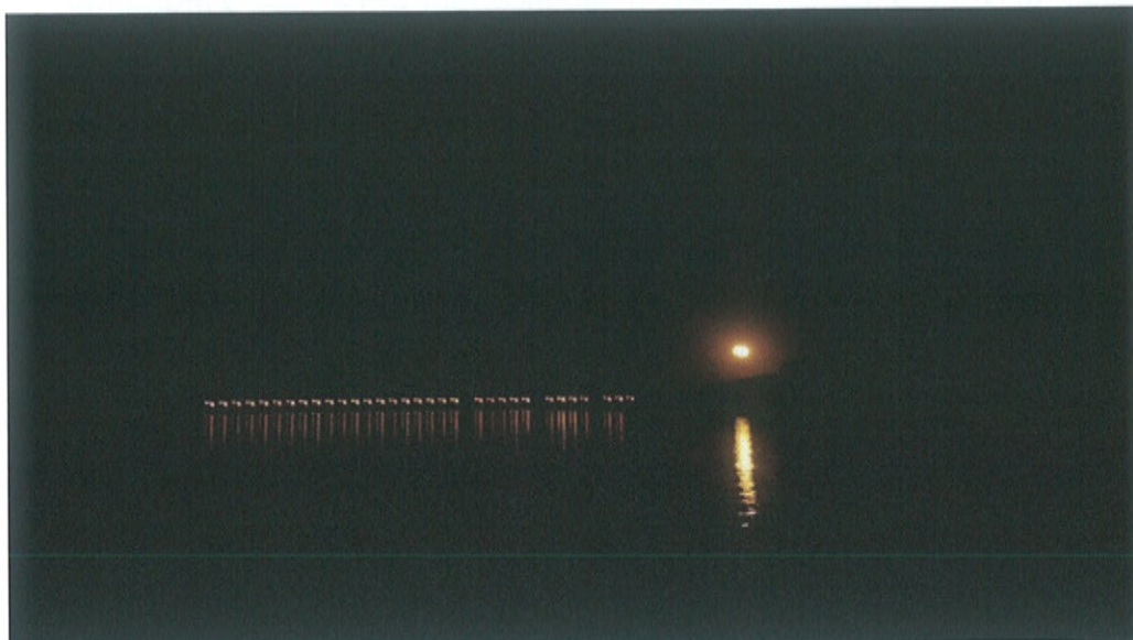
Figura 5: Visão da Ponte Internacional Brasil/Argentina, sobre o rio Uruguai. São Borja/Santo Tomé
