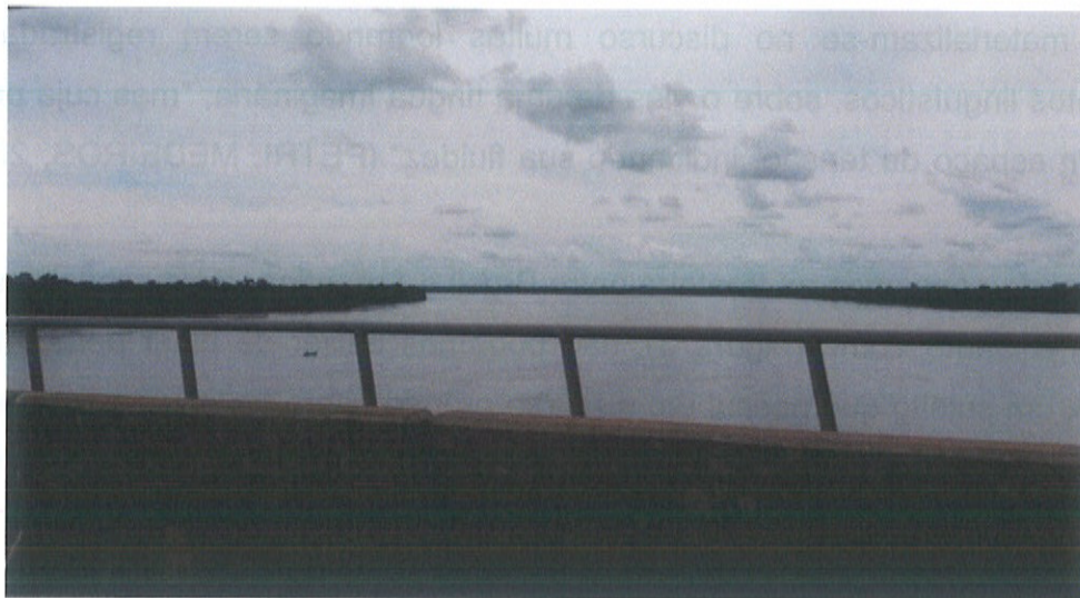
Figura 4: Ponte Internacional sobre o rio Uruguai, que integra Brasil e Argentina.
