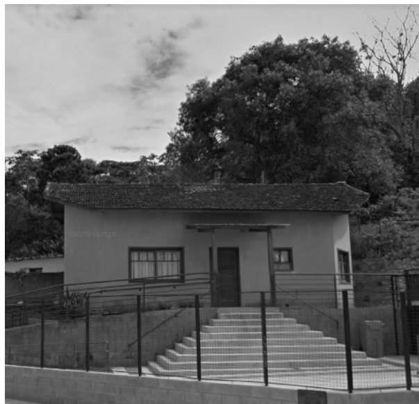
Figura 7 – Faixada do escritório da ABDSul, em Florianópolis – SC
