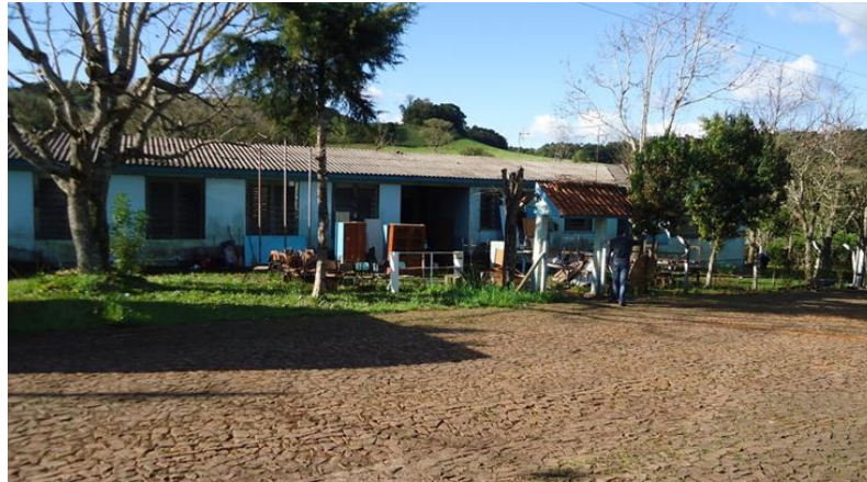
Figura 4 - Escola na comunidade de São Roque, e posteriormente, instalações do abrigo
