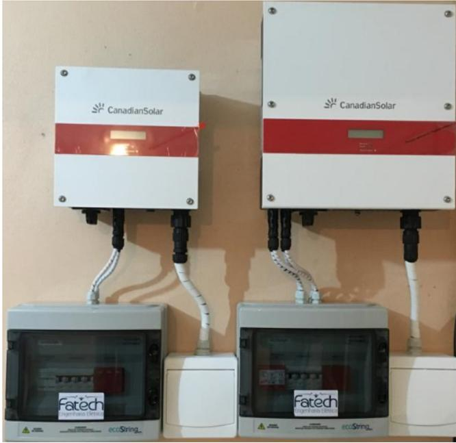
Figura 1: Inversores Solar Fotovoltaicos, da esquerda para direita, CSI-3K-MTL e CSI-5K-MTL, in loco.
