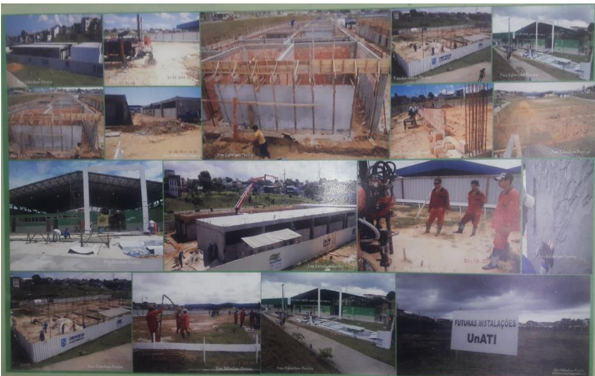
Figura 30 – Construção das Instalações da Fundação Universidade Aberta da Terceira Idade (FUnATI)
