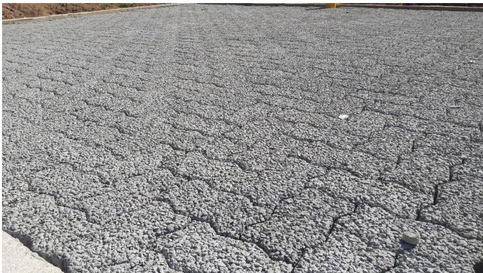
Figura 6 - Bloco de concreto permeável
