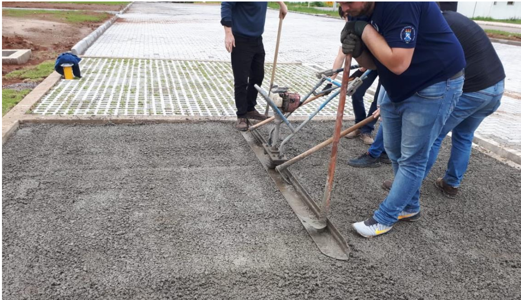
Figura 37 - Utilização da régua vibratória
