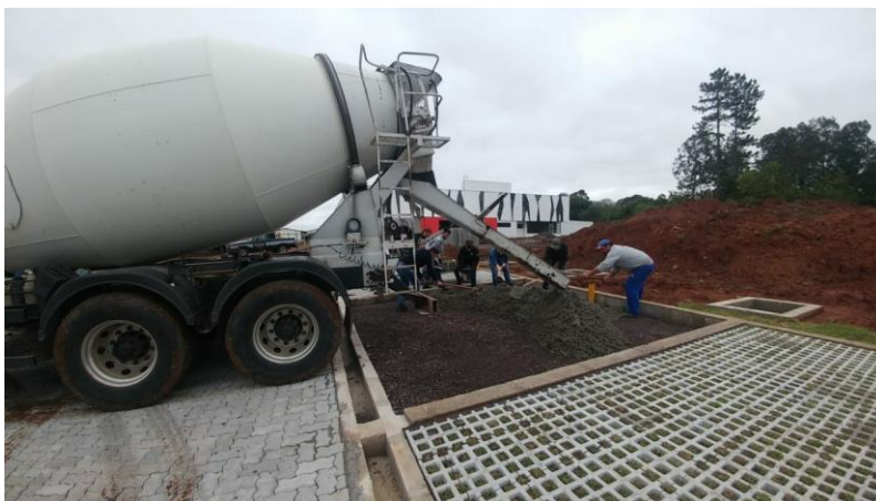
Figura 36 - Lançamento e espalhamento do concreto usinado
