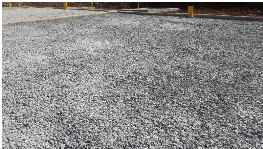
Figura 32 – Laje do estacionamento
