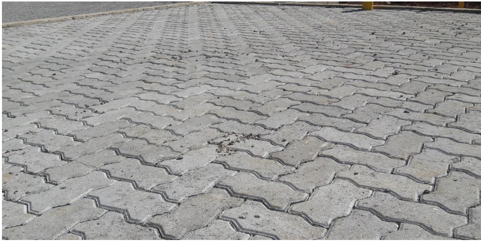
Figura 5 - Blocos de concreto
