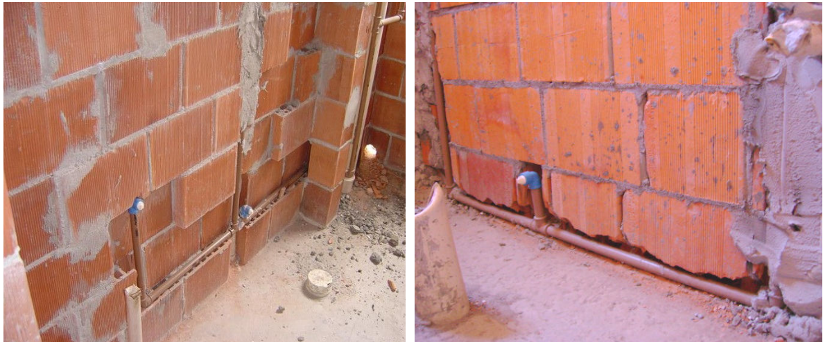
Figura 1 – Cortes para passagens de instalações em alvenaria estrutural de blocos cerâmicos
