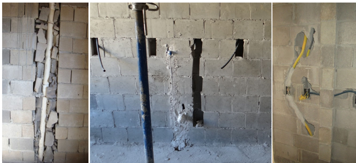
Figura 2 – Cortes para passagens de instalações em alvenaria estrutural de blocos de concreto
