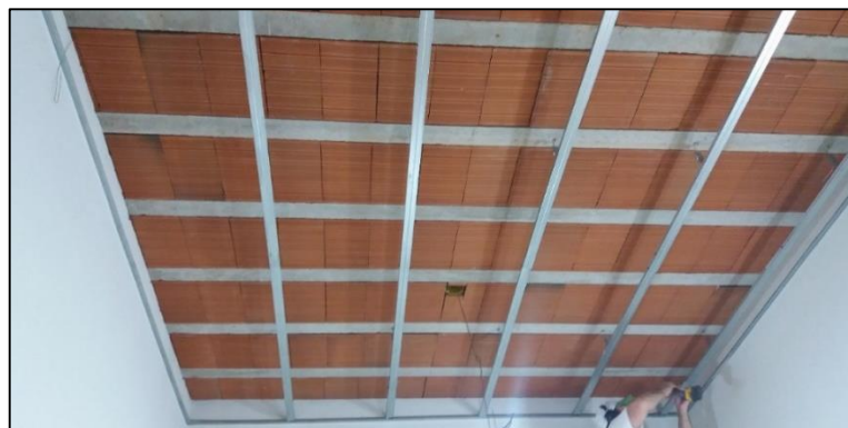
Figura 49 - Estrutura metálica para o sistema de forro de gesso acartonado.
