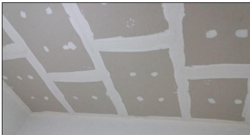
Figura 51 - Forro de gesso acartonado executado.
