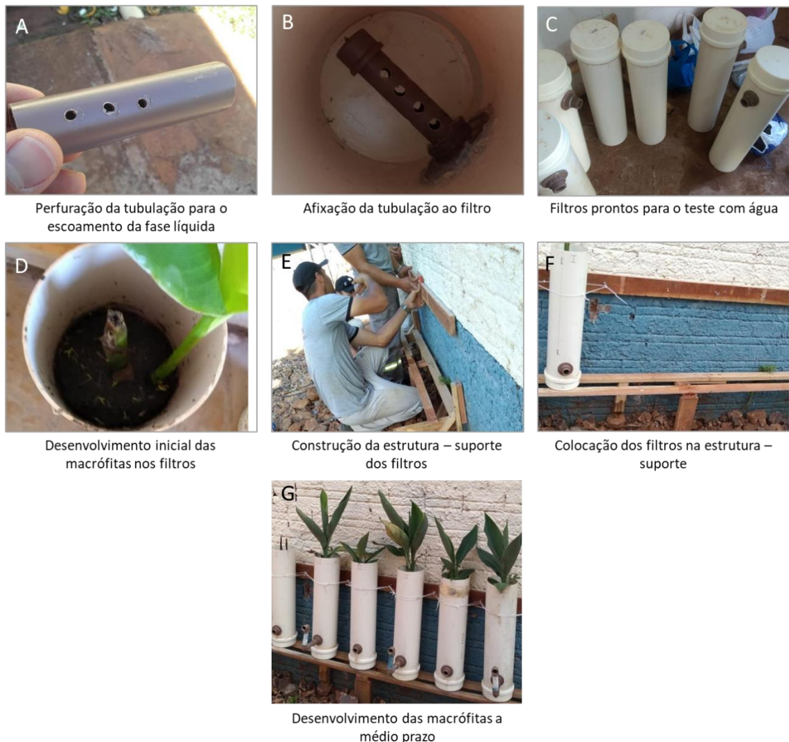
Figura 4.4 - Etapas de construção do experimento.
