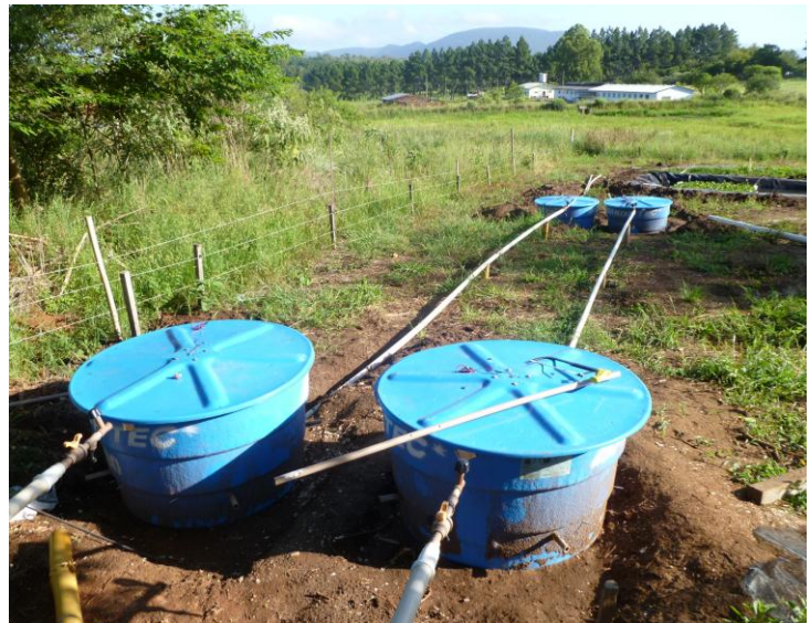
Figura 1 – Esquema dos biofiltros utilizados no tratamento de dejetos para obtenção da água residuária.
