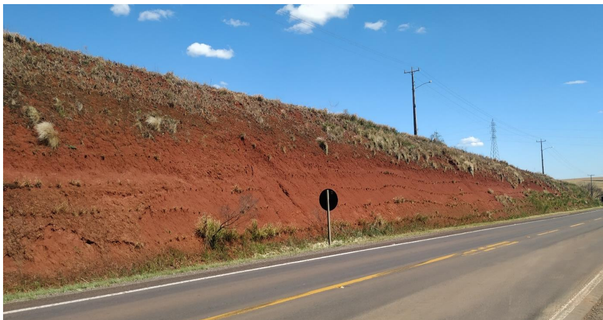
Figura 9 - Talude rodoviário revegetado com Capim-vetiver na cidade de Palmeira das Missões, RS.
