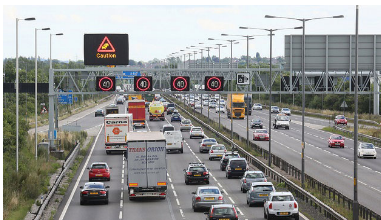
Figura 11 - Rodovia inteligente do tipo "todas as faixas operando"
