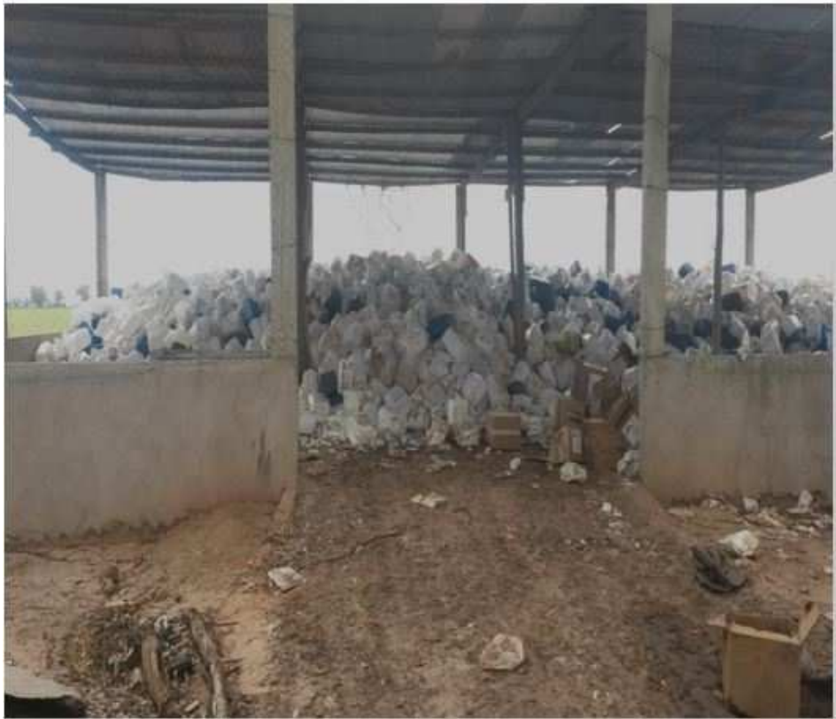
Figura 4- Galpão de armazenamento de embalagens vazias de agroquímicos.
