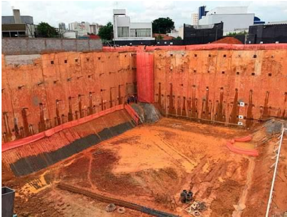
Figura 14 – Execução de parede diafragma rígida atirantada como solução de contenção e fluxo subterrâneo para implantação de níveis de subsolo
