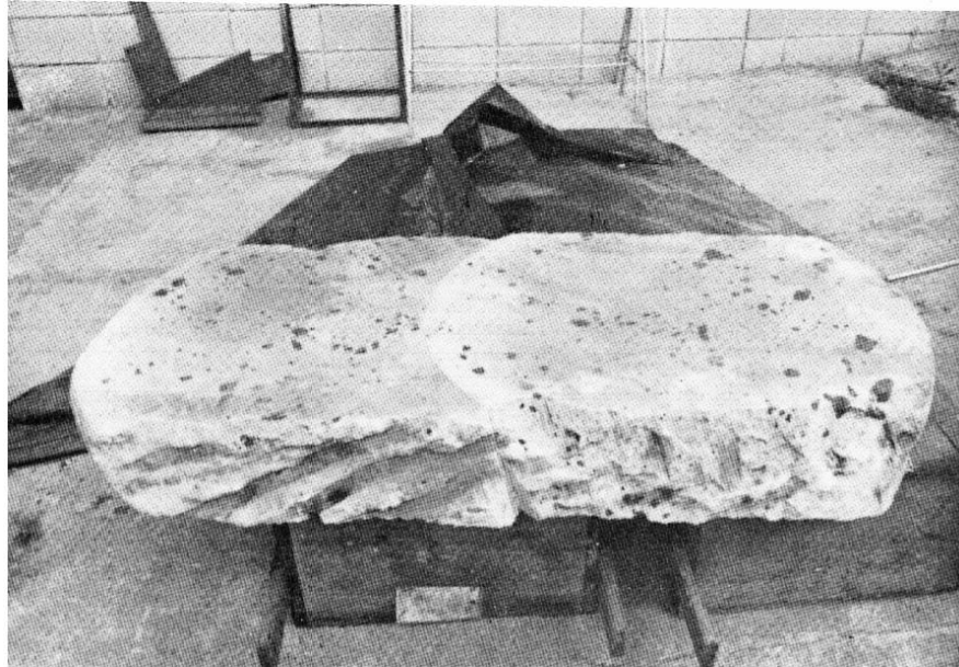
Figura 22 – Adesão entre colunas jet grouting formando um bloco único com grande adesão nas juntas construtivas e estanqueidade
