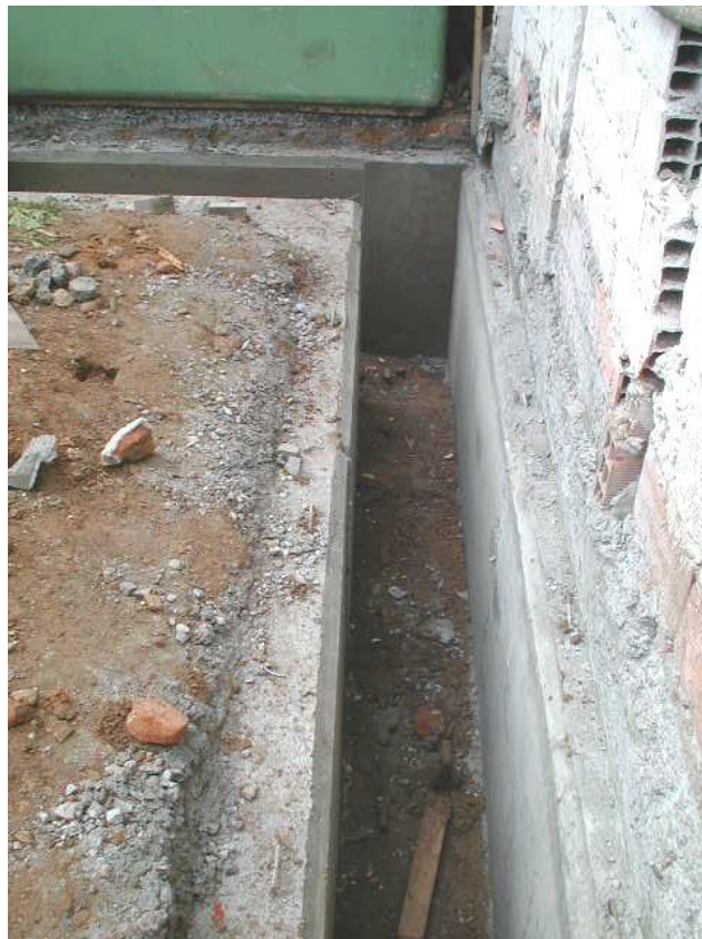
Figura 15 – Mureta guia executada em concreto armado para posterior execução de parede diafragma
