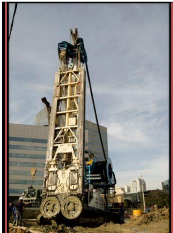
Figura 5 – Hidrofresa posicionada para iniciar escavação
