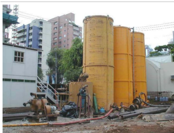
Figura 17 – Instalações da central de lama responsável pelo tratamento e limpeza do fluido utilizado
