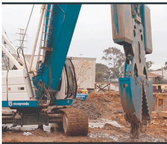
Figura 18 – Clamshell acoplado a guindaste de esteira inserindo sua garra no solo para desagregação do mesmo
