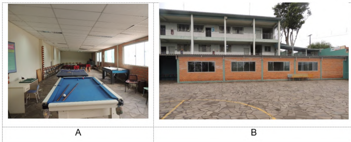
Figura 4.2 – Sala de jogos A) Ambiente interno B) Parede externa
