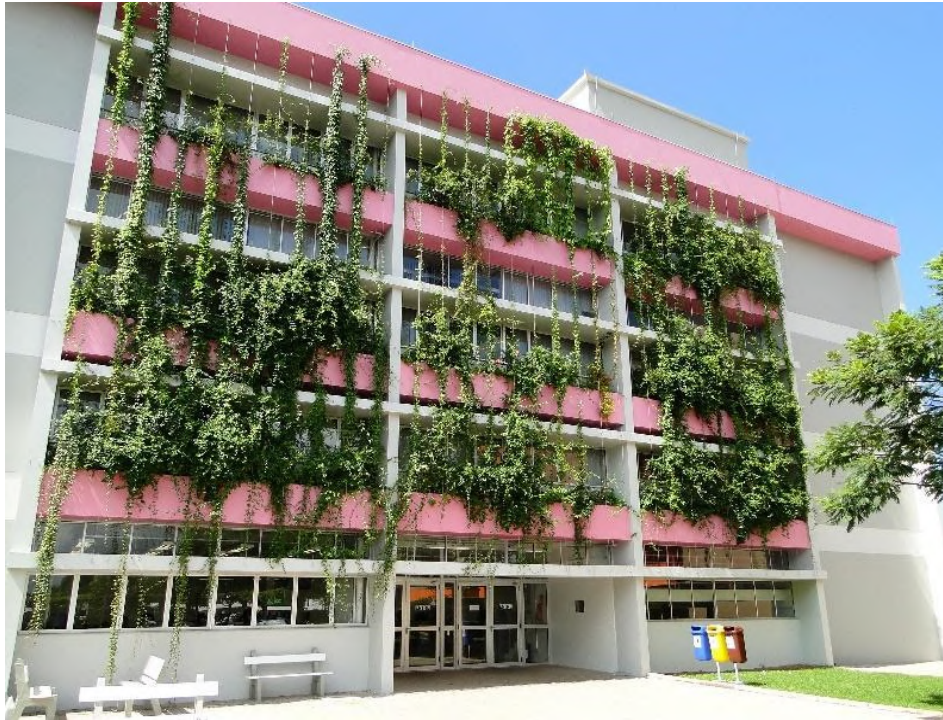
Figura 2.8 – Exemplo de aplicação de brise vegetal - Ecoparede Fevale
