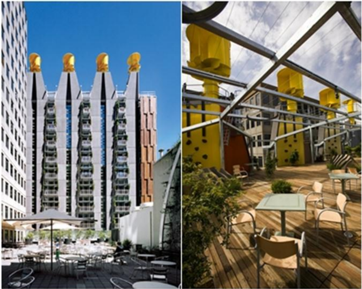
Figura 26 - Turbinas verticais reguladoras de temperatura.
