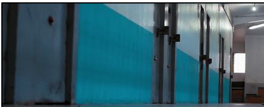
Figura 5: Corredor. Portas dos dormitórios
