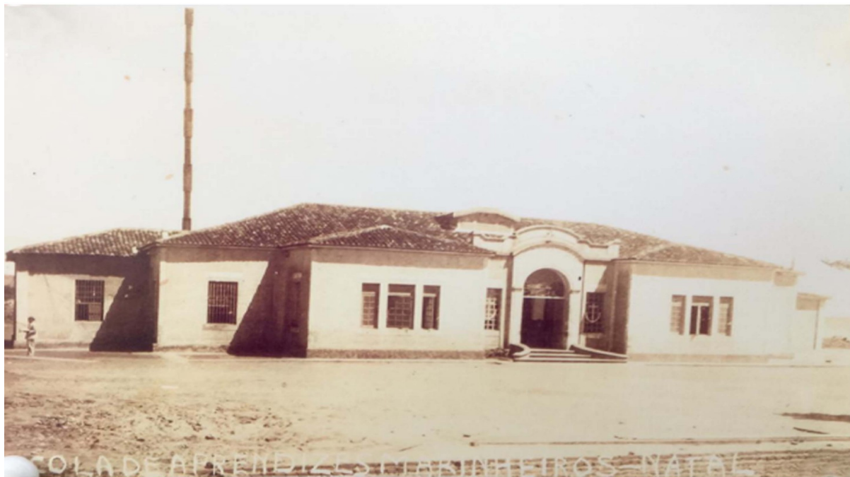
Imagem 25 – Prédio da Companhia de Aprendizes-Marinheiros do Rio Grande do Norte, s/d. Parte 2
