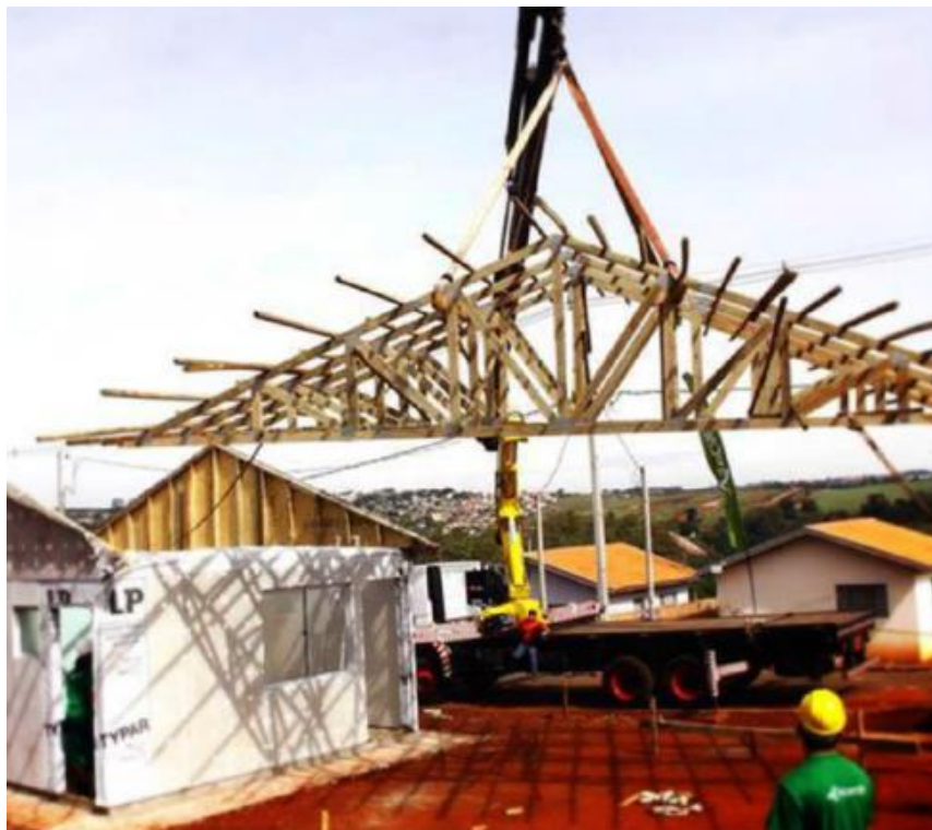
Figura 9: Içamento de treliça de madeira pré-fabricada
