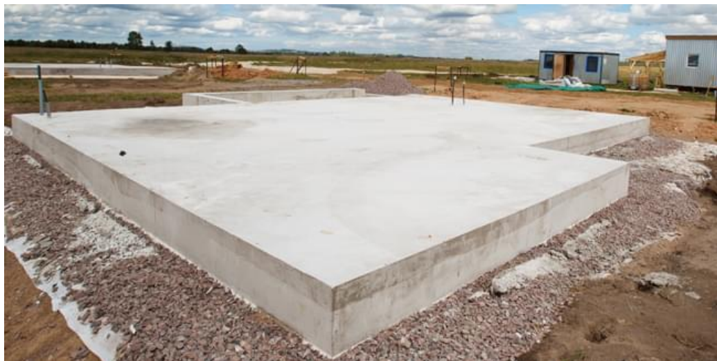
Figura 2: Fundação em radier
