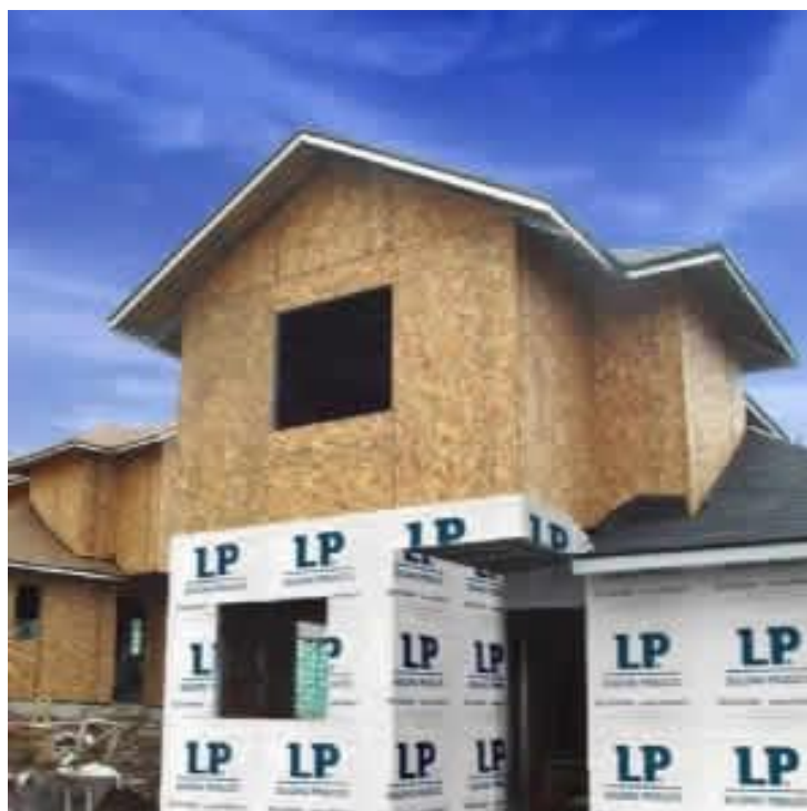
Figura 5: Membrana hidrófuga utilizada no sistema em wood frame
