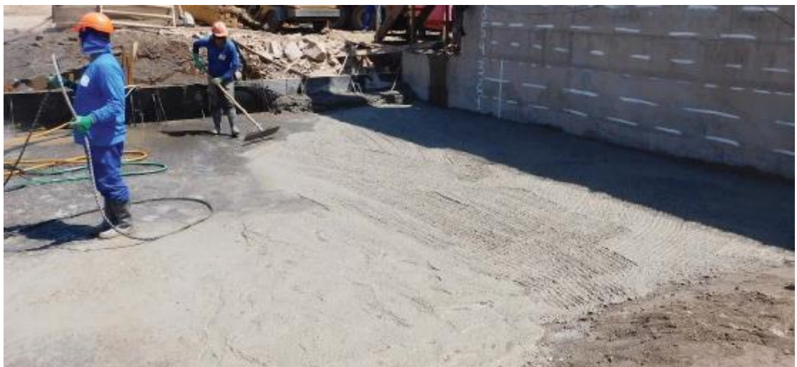
Figura 29 - Espalhamento Argamassa de Ligação
