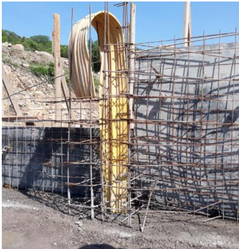
Figura 21 - Posicionamento e armação do veda junta fungenband
