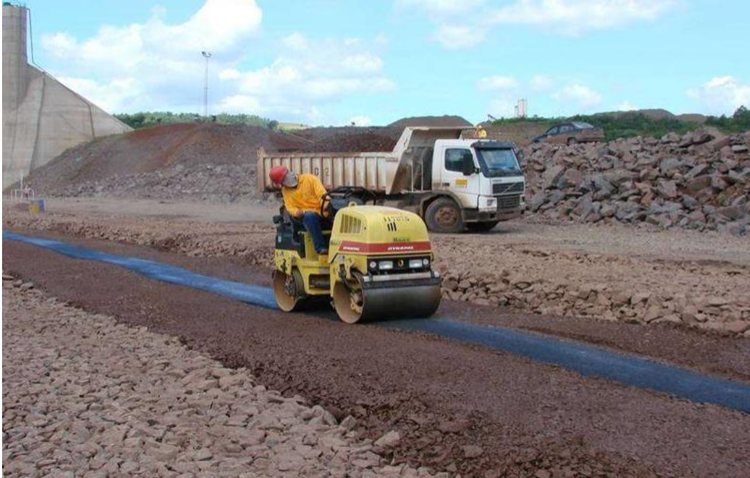
Figura 6 - Compactação do núcleo da UHE Foz do Chapecó.
