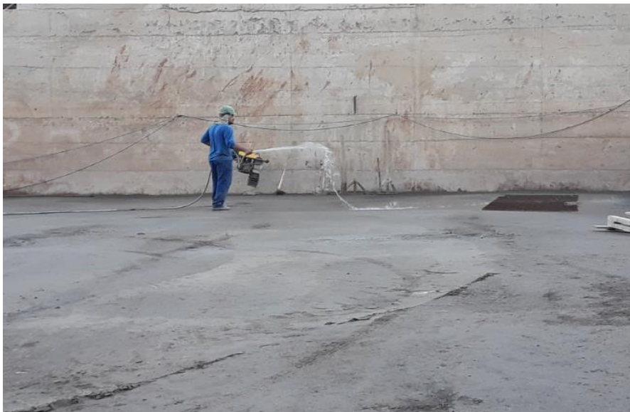
Figura 35 - Camada de CCR executada recebendo película e água para cura.
