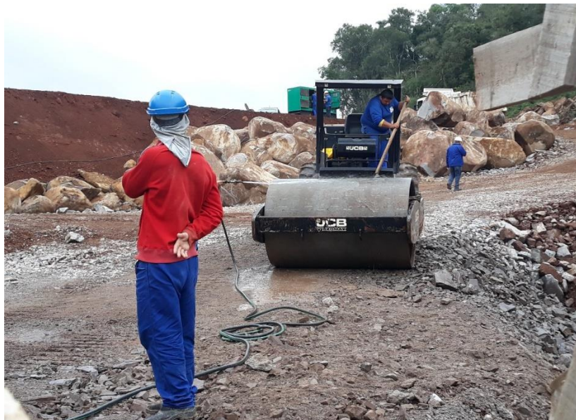
Figura 25 - Limpeza do rolo compactador antes de entrar em praça
