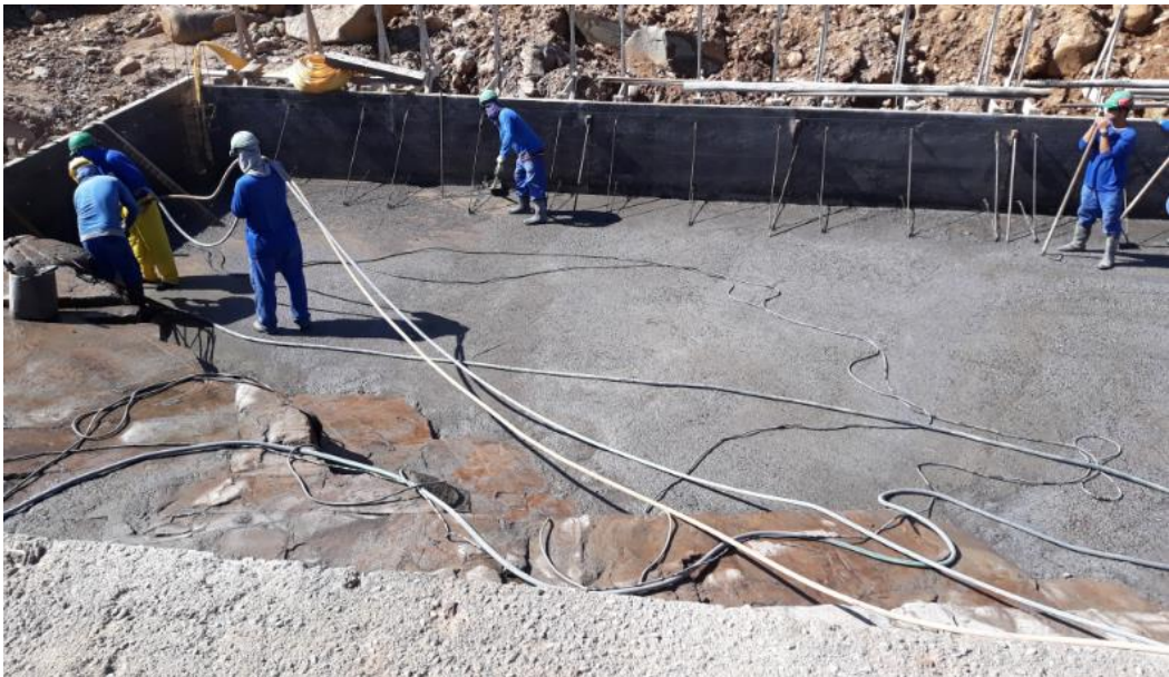
Figura 22 - Execução da regularização sobre a linha de rocha do bloco 04 B do vertedouro
