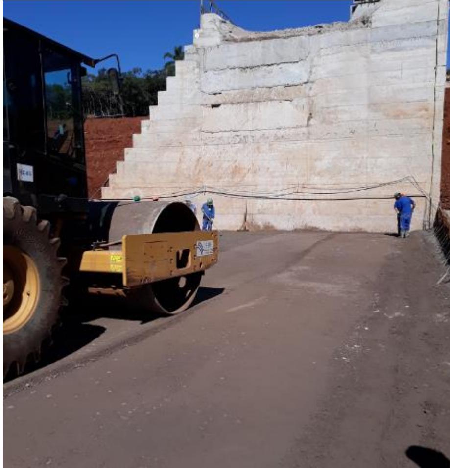
Figura 33 - Rolo vibrando camada de CCR
