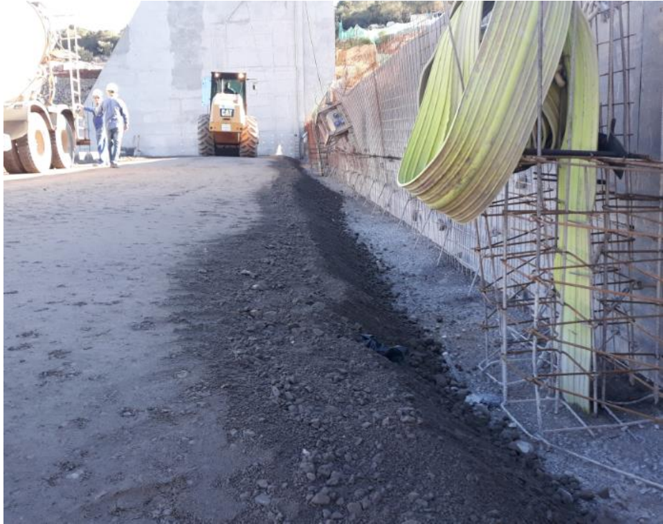
Figura 38 - Forma alternativa de lançamento de CCR
