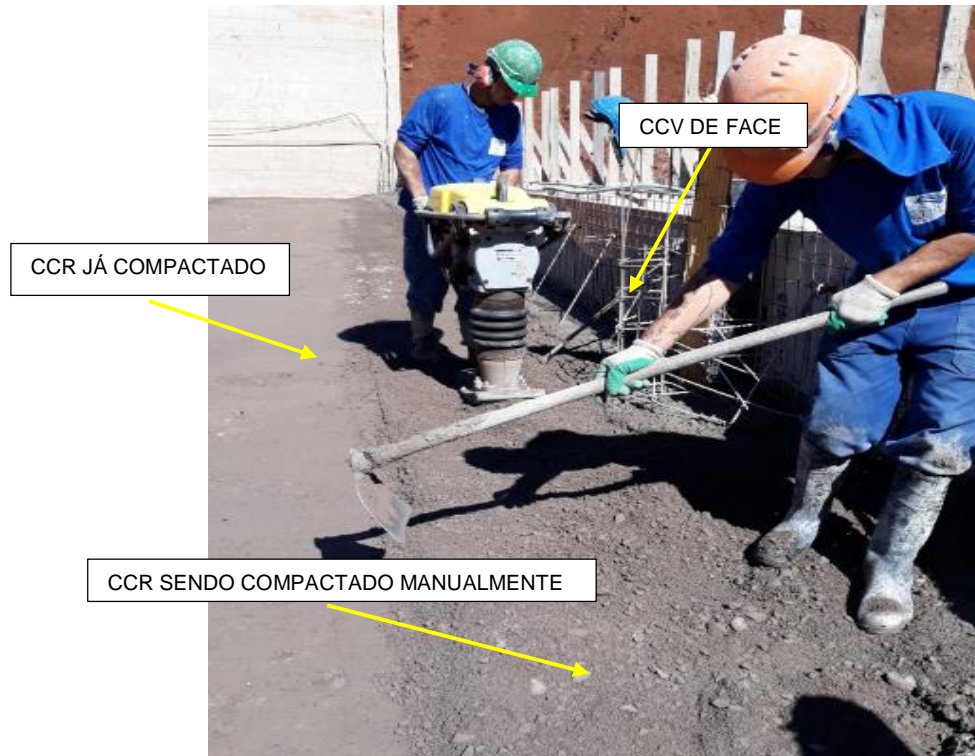
Figura 34 - Compactação com Compactador de Percussão
