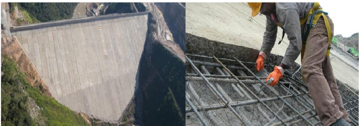
Figura 5 - Face de Concreto UHE Campos novos com detalhe para armadura pré-moldada para recuperação da Usina Hidrelétrica de Campos Novos
