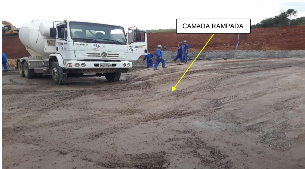
Figura 30 - Praça de CCR com camada finalizada no Método Rampado
