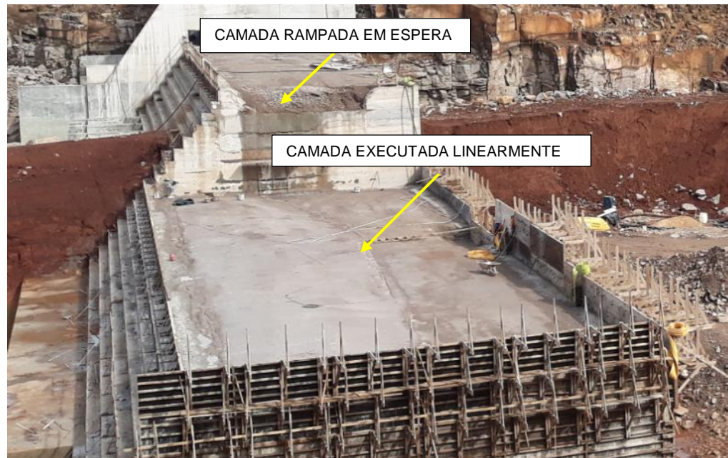
Figura 31 - Camada executado no Método Tradicional Linear
