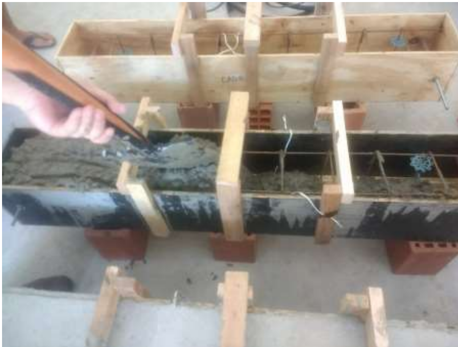
Figura 17: Concretagem das vigas.
