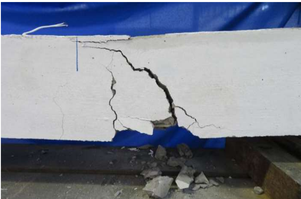
Figura 24: Ruptura da viga
