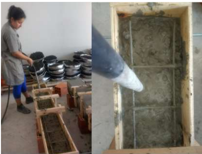
Figura 18: Adensamento do concreto.
