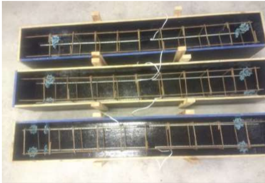
Figura 16: Formas das vigas.
