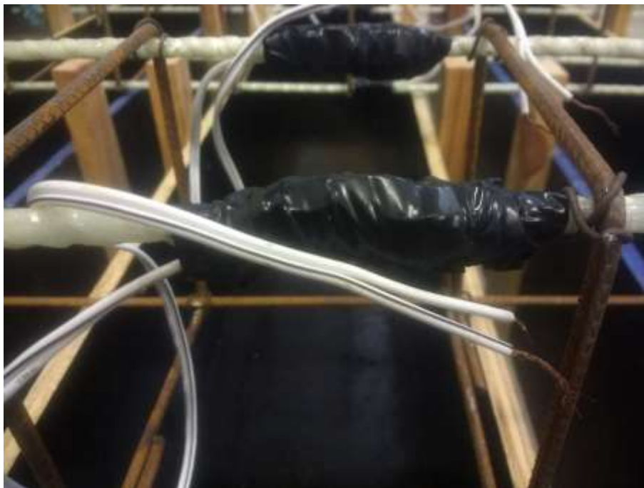
Figura 17: Detalhe das armaduras instrumentadas.
