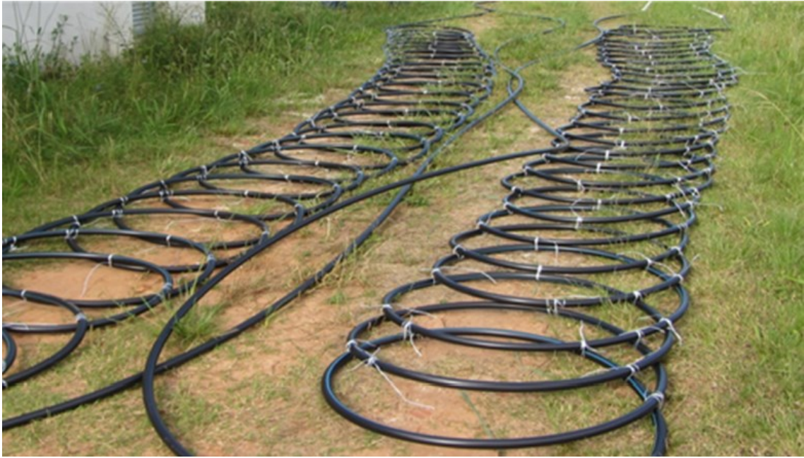
Figura 23 – Montagem do trocador geotérmico
