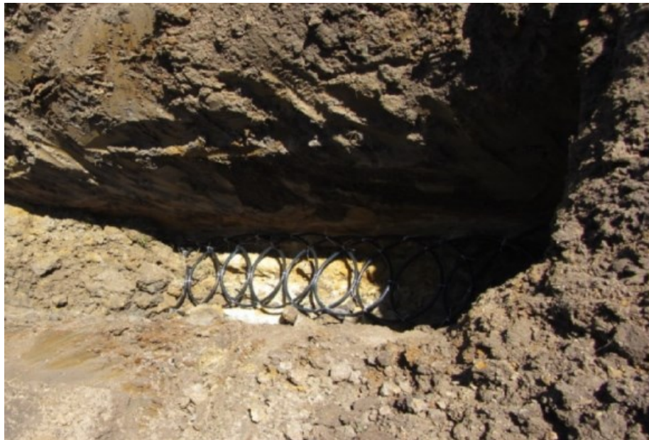
Figura 24 – Detalhe da mangueira enterrada a 5 metros de profundidade
