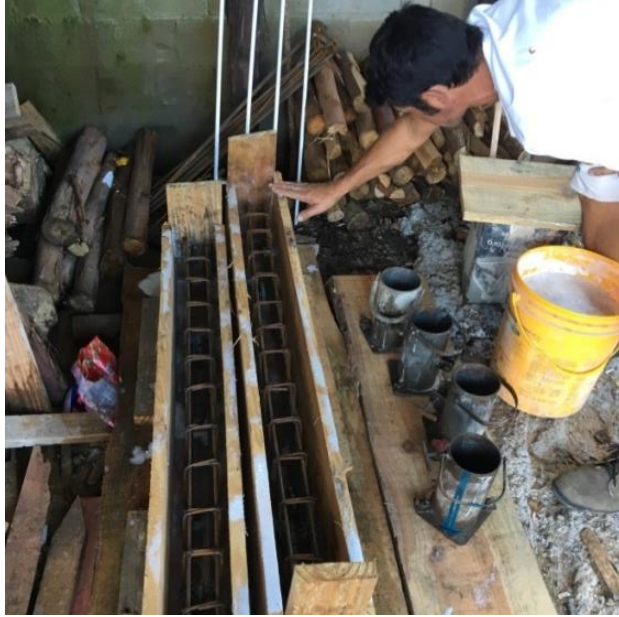
Figura 25 - Passagem de desmoldante e verificação dos cobrimentos
