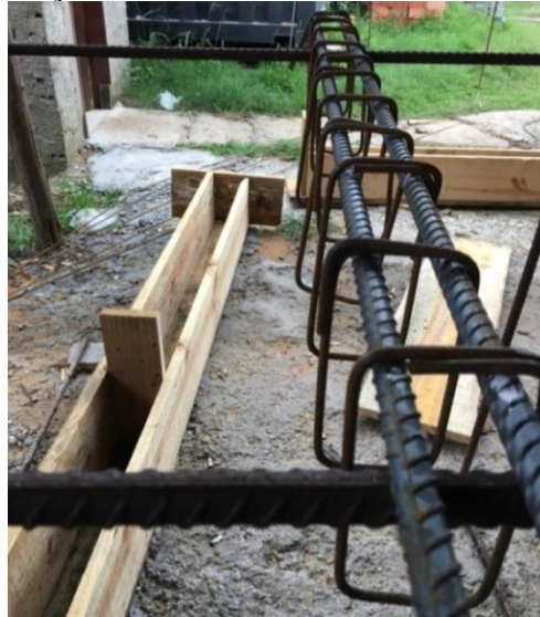
Figura 19 - detalhe - armação dos estribos
