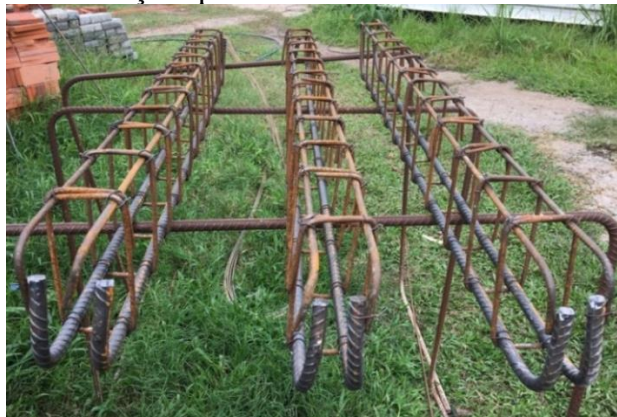
Figura 20 - detalhe - 3 armações prontas
