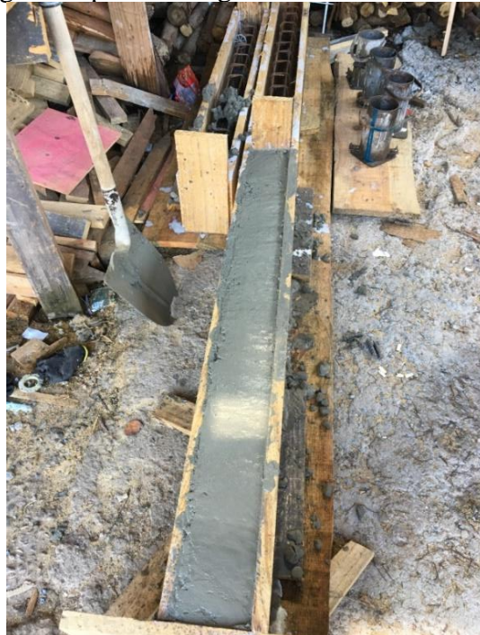
Figura 26 - Concretagem da primeira viga
