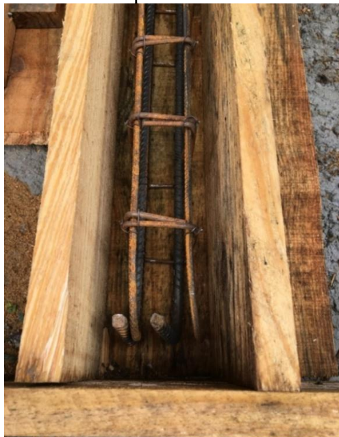
Figura 21 - Detalhe - cobrimentos respeitados
