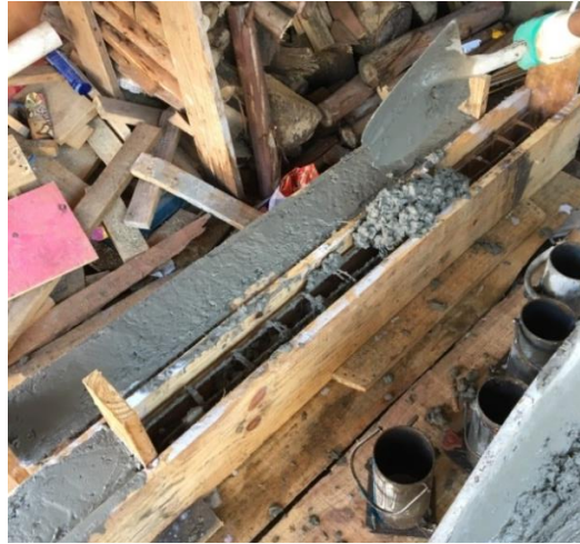
Figura 27 - Auxílio de uma pá no adensamento
