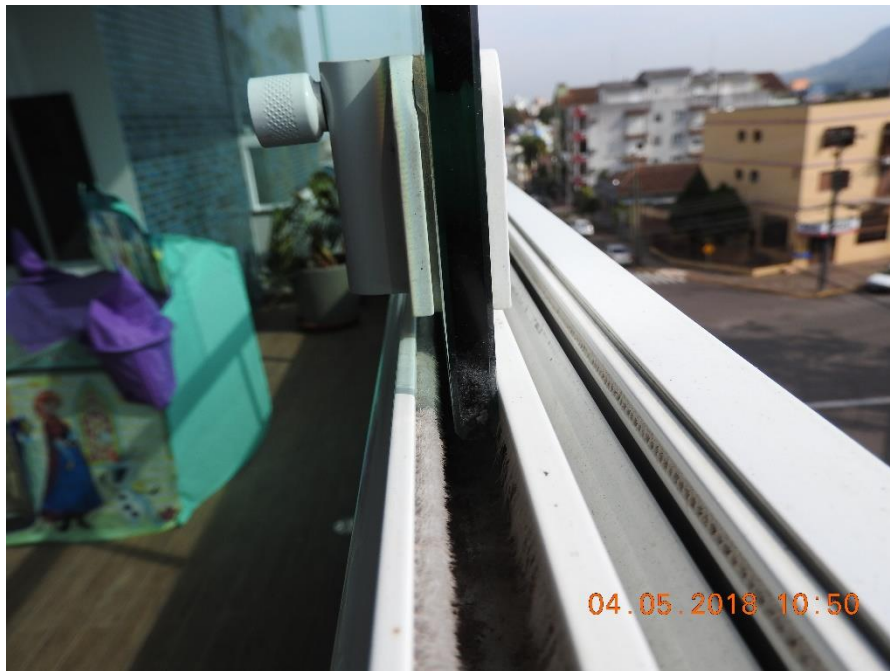
Figura 23 – Janela instalada na sacada
