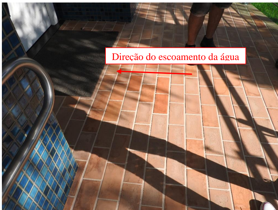
Figura 26 – Local onde a declividade da laje direciona a água para o interior do edifício
