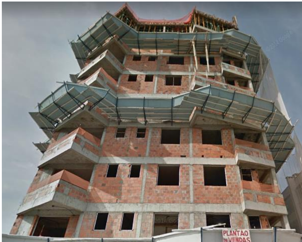
Figura 19 – Edifício em fase de construção
