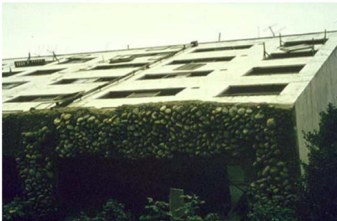
Figura 2.17: Liquefação – Niigata – JAP
