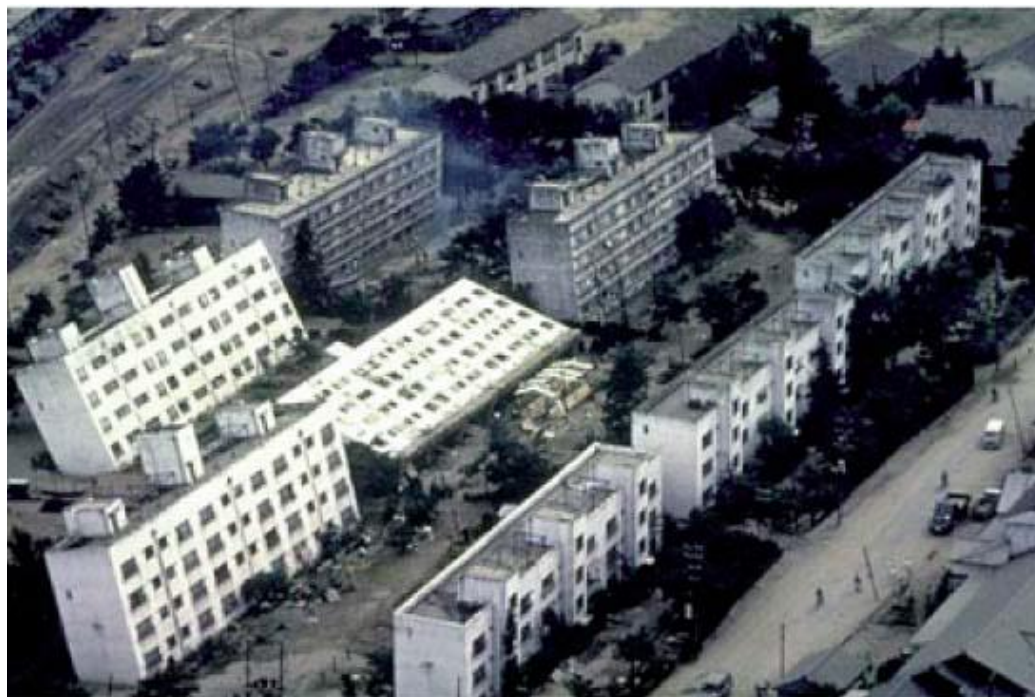
Figura 2.16: Liquefação – Niigata – JAP
