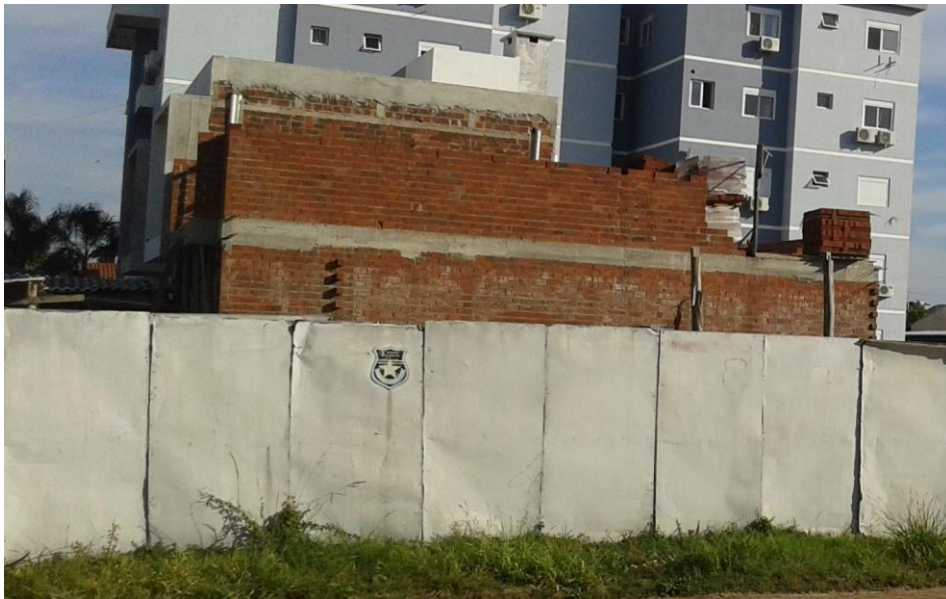
Figura 33 – Sobrados em construção na Quadra nº 232
