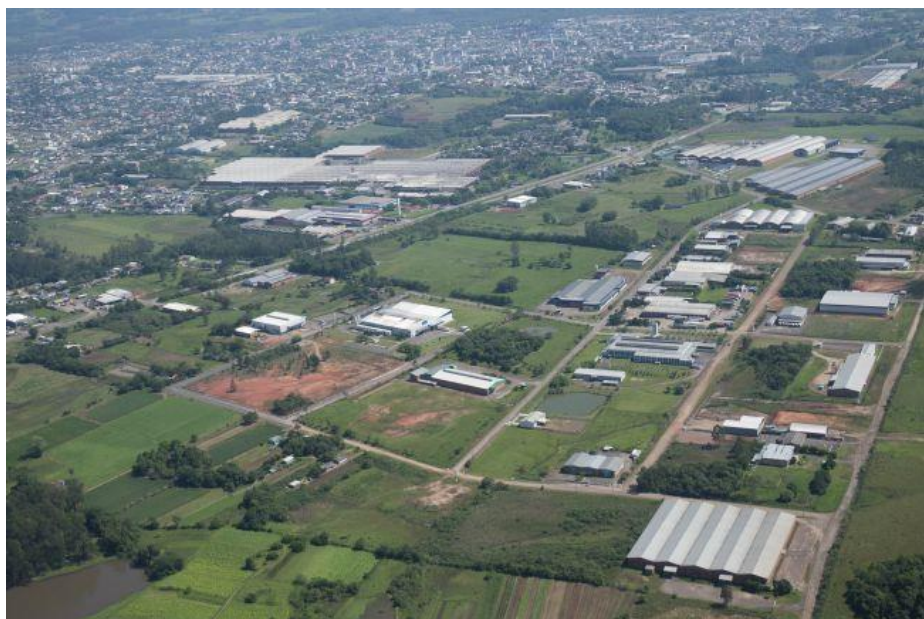
Figura 19 – Vista aérea do Distrito Industrial de Venâncio Aires-RS
