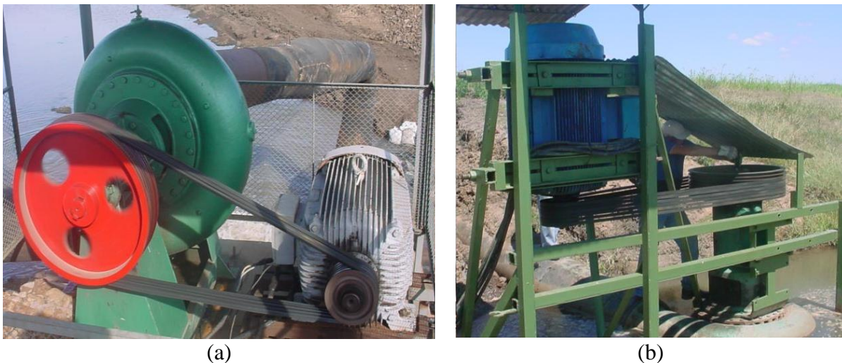
Figura 2.10 – Acoplamento por polia e correias (a) eixo horizontal e (b) eixo vertical.
