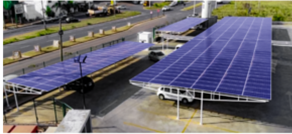
Figura 4.17 – Instalação dos módulos na estrutura de carport solar.
